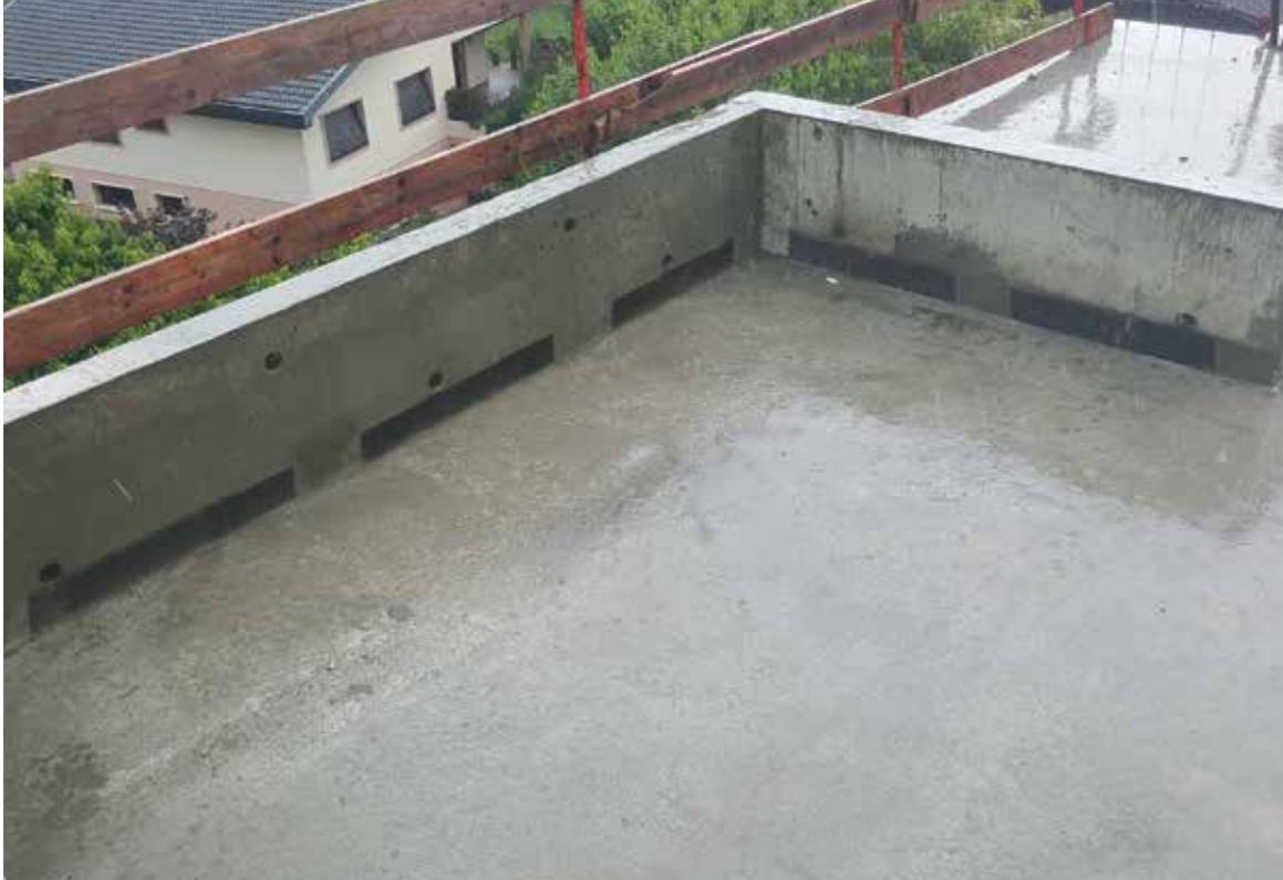
Le respect de la **règlementation thermique** impose le traitement des ponts thermiques en fixant des seuils de déperdition thermique linéique à ne pas dépasser. Parmi ces ponts thermiques, celui généré par la réalisation d'acrotères en béton armé est important puisque périphérique à l'ensemble des toitures terrasses.
