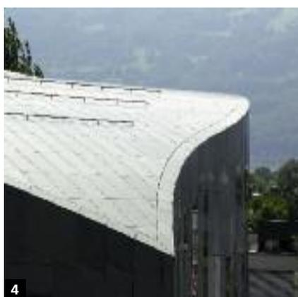
Nella realizzazione di tetti in metallo, lo zinco titanio, l'alluminio, il rame e l'acciaio inossidabile sono i materiali più utilizzati. Questi materiali vengono posati sopra l'isolante FOAMGLAS® secondo le regole dell'arte della carpenteria.
