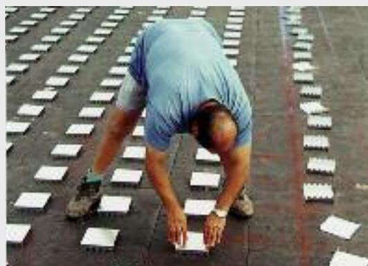
Per la posa della copertura, le strutture isolanti con FOAMGLAS® non richiedono alcun ancoraggio meccanico passante. La copertura in lamiera viene montata sulle piastre dentate.
