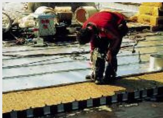
In un tetto caldo, ad esempio realizzato con fibre minerali o schiume sintetiche, il fissaggio ha luogo in modo meccanico tra la copertura metallica e il guscio portante. La conseguenza è la creazione di ponti termici, ci si affianca la domanda: quanto è sicura la barriera contro l'aria/il vapore?
