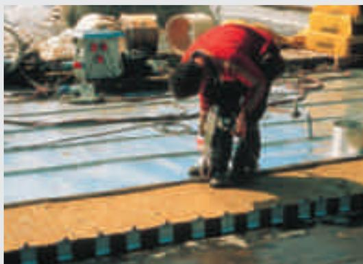
Dans les toitures chaudes avec par exemple de la fibre minérale ou du plastique cellulaire expansé, la fixation se fait mécaniquement entre la couverture métallique et la coque portante, avec pour conséquence l'apparition de ponts thermiques. Une question supplémentaire se pose: quelle est la fiabilité du pare-vapeur/pare-air?
