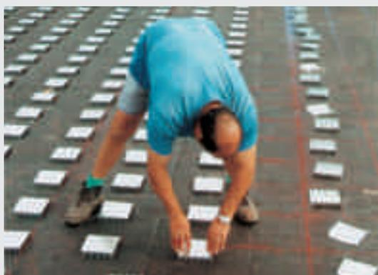
Les constructions d'isolation avec FOAMGLAS® ne nécessitent aucun ancrage mécanique traversant pour la pose de la couverture. La couverture métallique est montée sur les «plaques à crampons».
