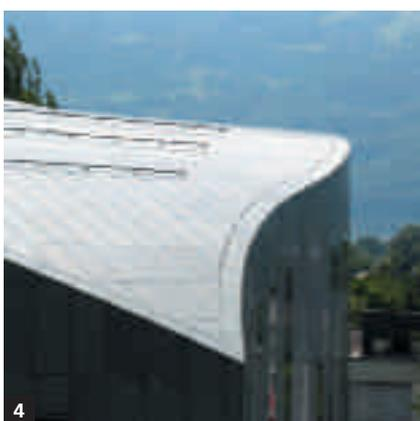
Pour l'exécution des toitures métalliques, le zinc titane, l'aluminium, le cuivre et l'acier inoxydable sont essentiellement utilisés. Ces matériaux sont mis en œuvre sur FOAMGLAS® selon les règles de l'art de la ferblanterie.
