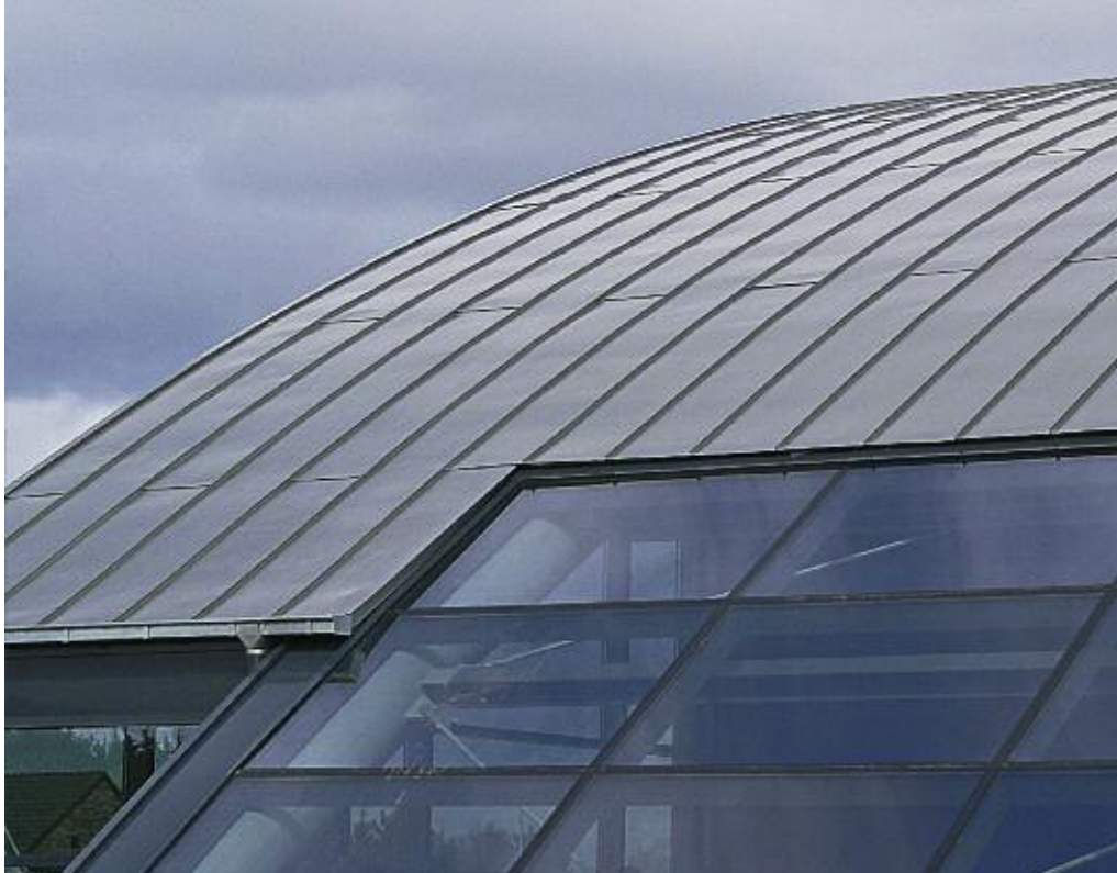
Tôle cintrée, nouveau bâtiment, zinc
