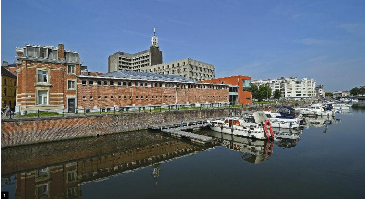
1 Piscine Van Eyck, Gand, Belgique Architectenburo Ro Berteloot, Gand, Belgique
