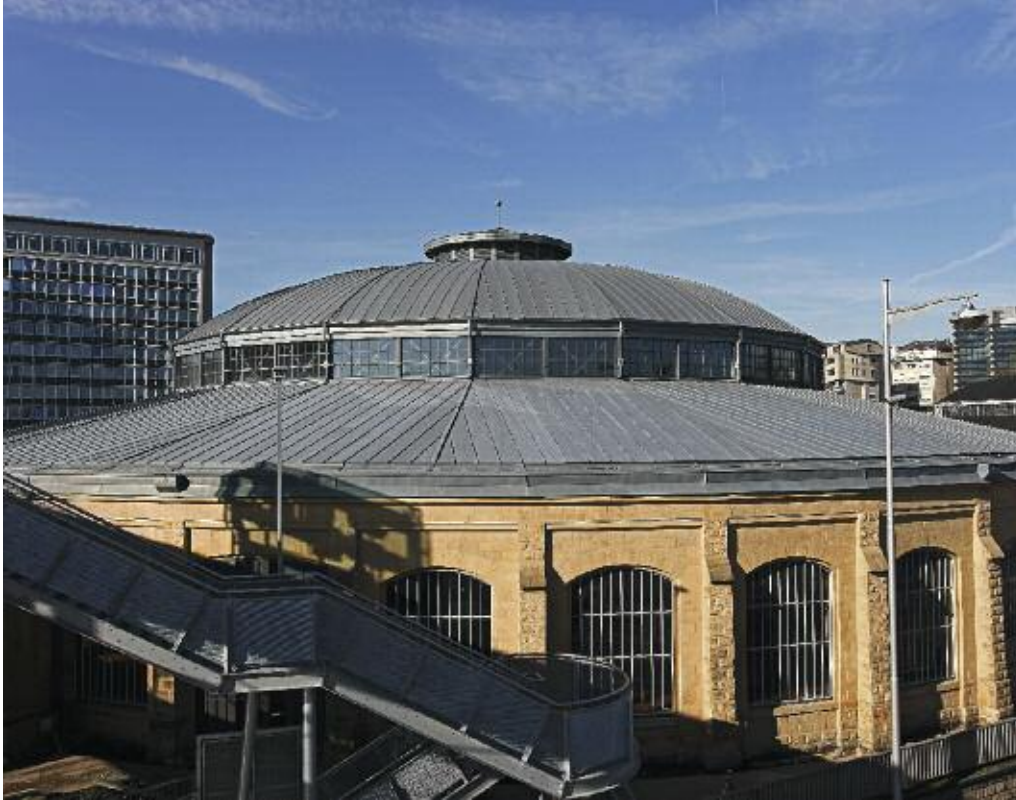
Toiture métallique, rénovation, zinc
