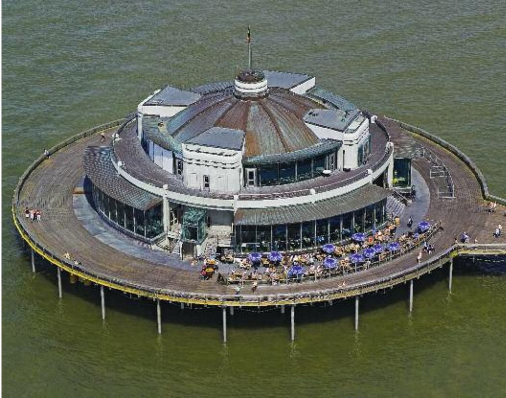
Toiture cintrée, rénovation, cuivre
