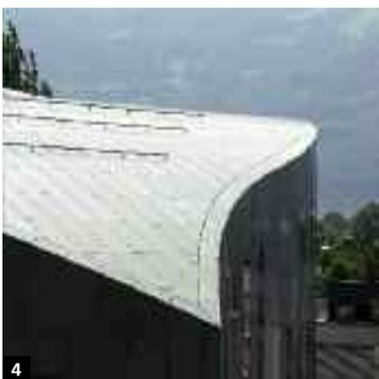
Bei der Ausführung von Metalldächern stehen Titanzink, Aluminium, Kupfer und nichtrostender Stahl im Vordergrund. Diese Werkstoffe werden nach den Fachregeln des Spengler-Handwerks auf FOAMGLAS® verarbeitet.
