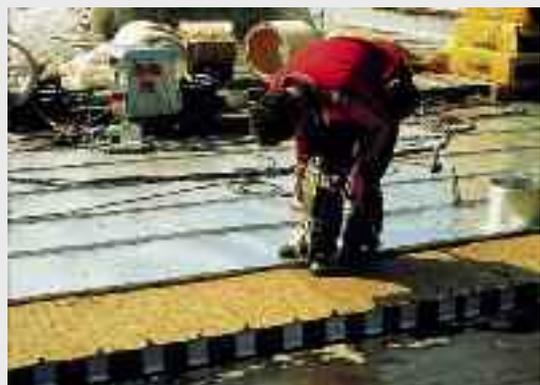
Im Warmdach mit z. B. Mineralfasern oder Schaumkunststoff wird zwischen Metalleindeckung und tragender Schale mechanisch durchbefestigt. Die Folge: Wärmebrücken! Zusätzlich die Frage: Wie sicher ist die Dampf-/Luftsperr?
