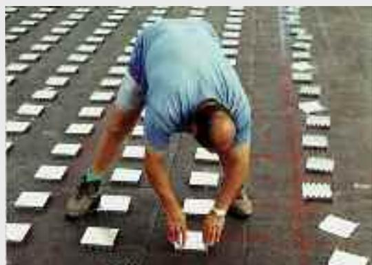
FOAMGLAS®-Dämmkonstruktionen benötigen zur Aufnahme der Eindeckung keine mechanisch durchgehenden Befestigungsmittel. Die Blecheindeckung wird auf die «Krallenplatten» montiert.
