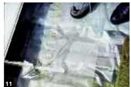
brochen bzw. perforiert. Kondensat in der Dämmschicht und Korrosion der Befestiger sind dann ebenso zu befürchten wie Wärmebrücken.
