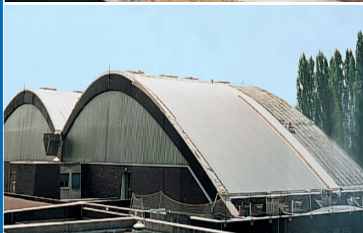
Universidad Politécnica de Ingeniería en Palaiseau (Francia) Rehabilitación de la cubierta con bandejas perfiladas KAL-ZIP
