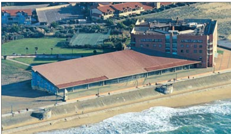
Centro Europeo para la Rehabilitación de Atletas (Centre Européen de rééducation du Sportif), Cap Breton, Francia. Cuando se rehabilitó el edificio, se diseñó una cubierta compacta FOAMGLAS® utilizando un sistema de chapas de cobre.
