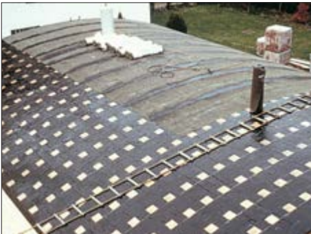
Ejemplo de cubierta curvada con aislamiento en placas T4 FOAMGLAS® y placas de fijación PC® para sujetar las chapas metálicas. Aplicación de una membrana de impermeabilización a plena adherencia mediante calor.
