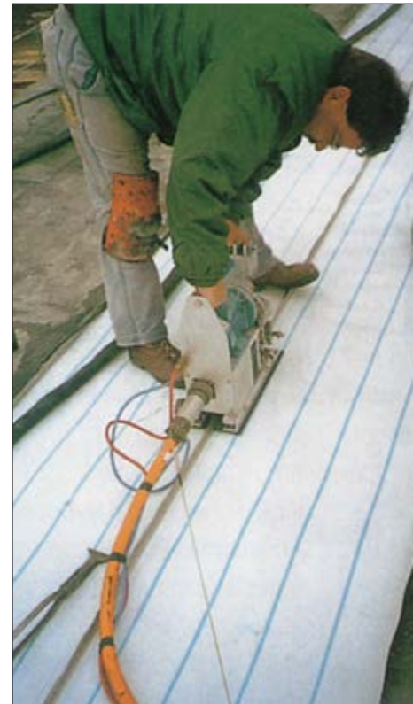
Soldadura plegada de las chapas en acero inoxidable.
