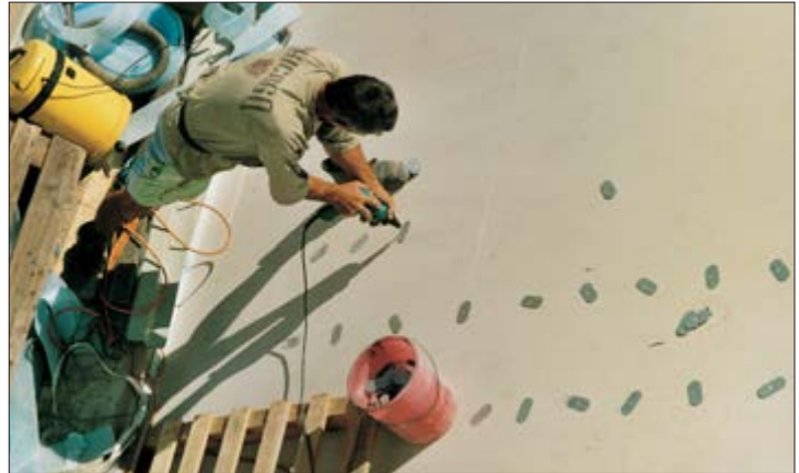
Paneles acústicos PC® de 2 x 10 mm de espesor atornillados sobre los perfiles Z con tornillos auto-perforadores y discos de apoyo.
