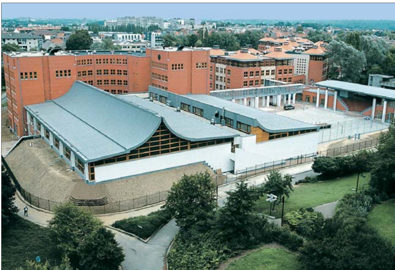
Pabellón deportivo de la Escuela europea en Bruselas, con bandejas perfiladas de zinc.
