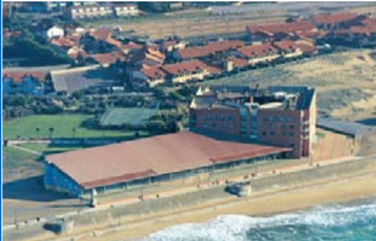
Rehabilitación de la piscina del Centre Européen de Rééducation du Sportif (Centro Europeo para la Rehabilitación de Atletas); Cap Breton (Francia)
