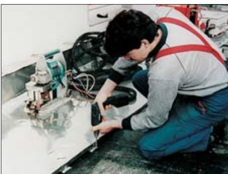
Atornillado de los clip deslizantes a las placas de fijación PC®.
