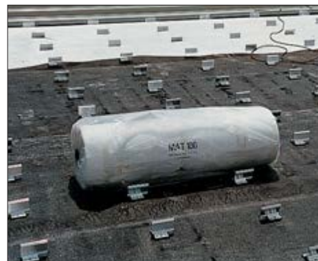
Foto 1: Instalación de una losa estructurada no laminada (Enkamat), como capa de separación por debajo del revestimiento metálico de titanio-cinc sin protección anti-corrosiva, del fabricante Rheinzink por ejemplo.
