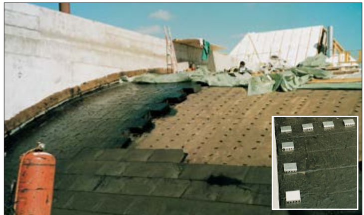
Paneles acústicos PC® de 2 x 10 mm de espesor atornillados sobre los perfiles Z con tornillos auto-perforadores y discos de apoyo.
