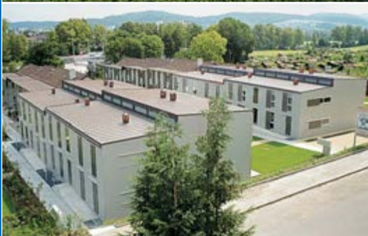
Complejo residencial de Langgasse, Winterthur (Suiza)
