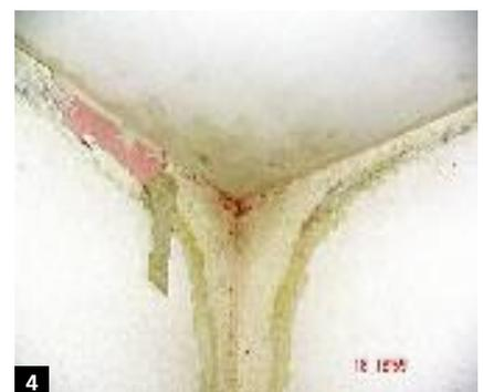
surfaciennes trop basses sur la face interne des murs extérieurs. Une isolation intérieure en FOAMGLAS® peut y remédier. En effet, l'isolation augmente la température superficielle sur la face interne d'un mur extérieur. Il ne se forme pas de condensation et les moisissures se voient privées de leur milieu nourricier. Cela signifie pour les habitants un plus en matière d'hygiène d'habitation, de santé et de qualité de vie. Une dépense raisonnable permet donc d'obtenir des effets importants.
