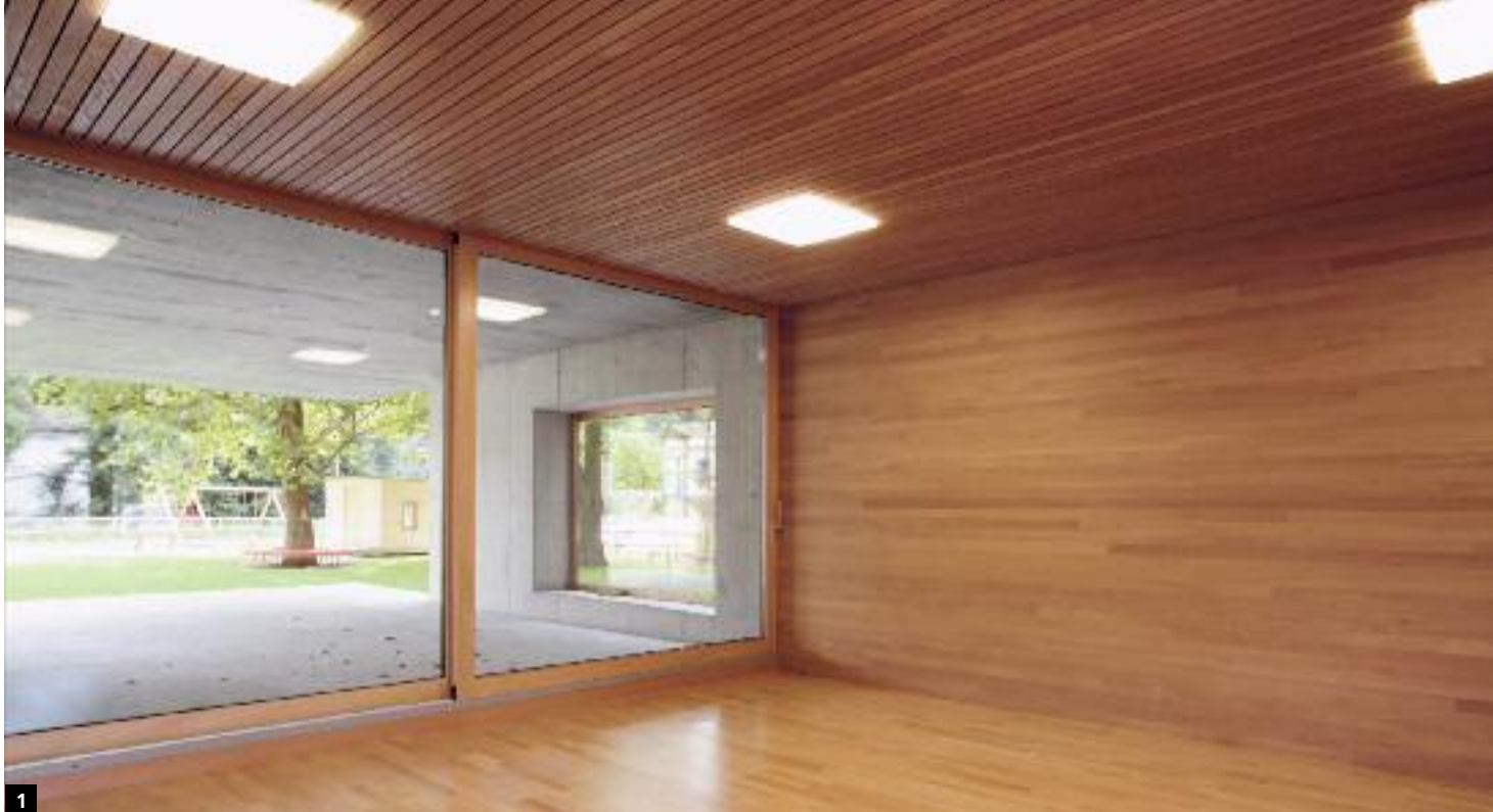
1 Jardin d'enfants Iramali, Balzers 2-4 Humidité et moisissures
