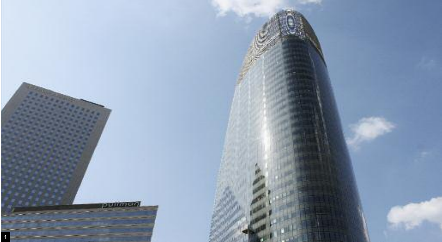
1 Restaurant inter-entreprises, Tour GDF SUEZ, Paris La Défense, architecte Valode & Pistre
