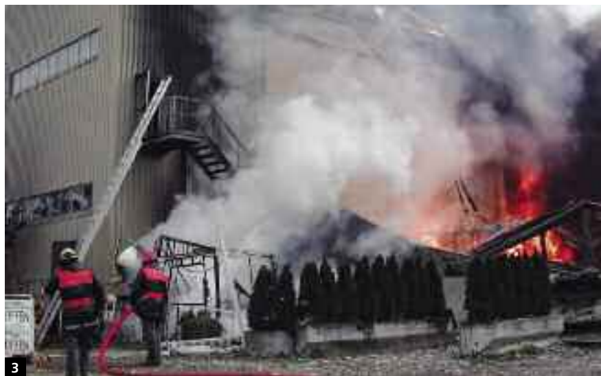
3 Brandausbreitung über Fassade und Dach ist oft Ursache verheerender Gesamtschäden
