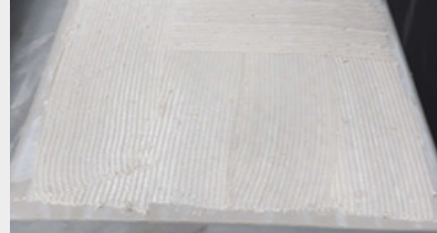
Lijm op grootformaattegel
