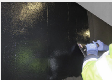
Étalement du coating
