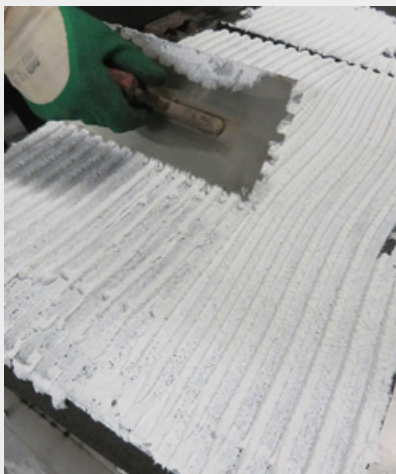
Colle sur l'isolation FOAMGLAS® T3+
