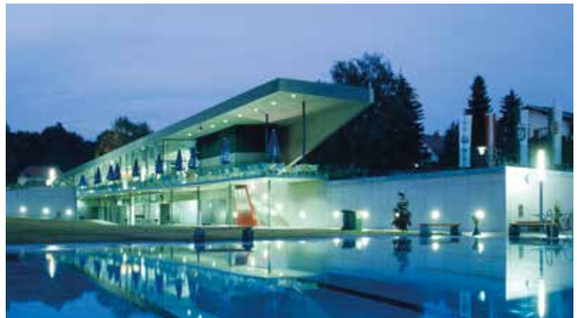
Wellenbad Gleisdorf , Österreich. Architekt: Pittino & Ortner. FOAMGLAS® Innen- und Kerndämmung. Foto: © paul ott fotografiert
