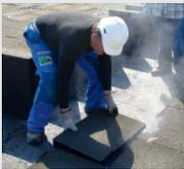
Plaques FOAMGLAS® posées au bitume à chaud
