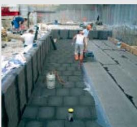
Plaques FOAMGLAS® posées au bitume à chaud
