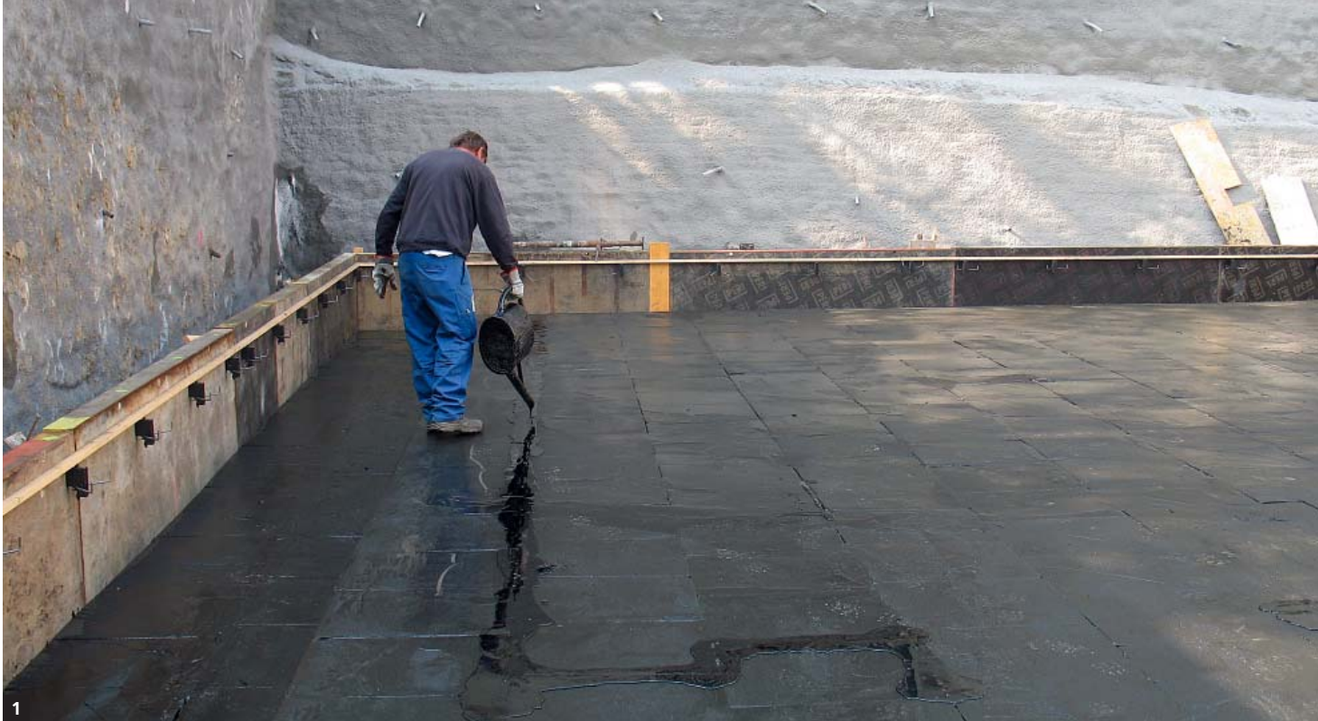
1 Rasatura con bitume caldo.
