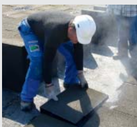
Lastre FOAMGLAS® con bitume caldo
