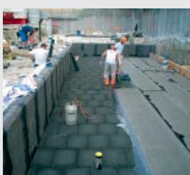
Lastre FOAMGLAS® con bitume caldo
