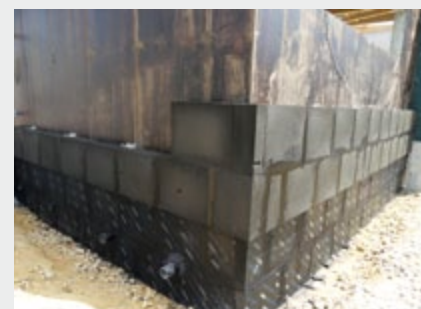
- Remblai sur l'isolant FOAMGLAS® - Jonction thermique entre la partie enterrée et la façade
