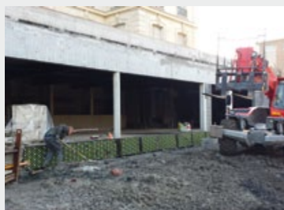
Mise en oeuvre des panneaux FOAMGLAS® WALL BOARD
