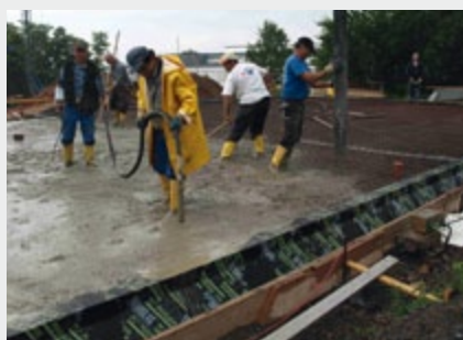
- Pose des panneaux FOAMGLAS® FLOOR BOARD - Coulage du radier
