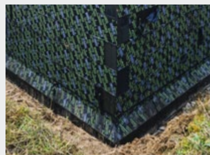
- Réalisation des pièces de bordure PC® PERISAVE - Disposition des blocs de socle PC® PERISAVE
