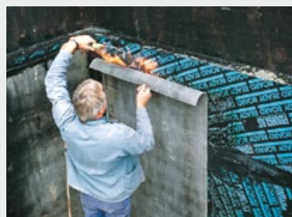
- Soudage d'une membrane bitumeuse sur l'isolant.
