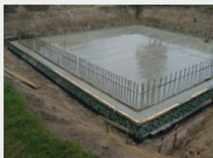
- Mise en oeuvre des pièces de bordure PC® PERISAVE - Séchage du radier
