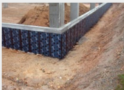
Isolant FOAMGLAS® BOARD en soubassement
