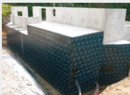
Pose des panneaux Board avec la colle PC® 56
