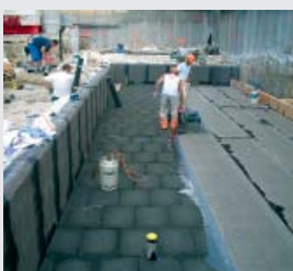
FOAMGLAS® Platten mit Heissbitumen
