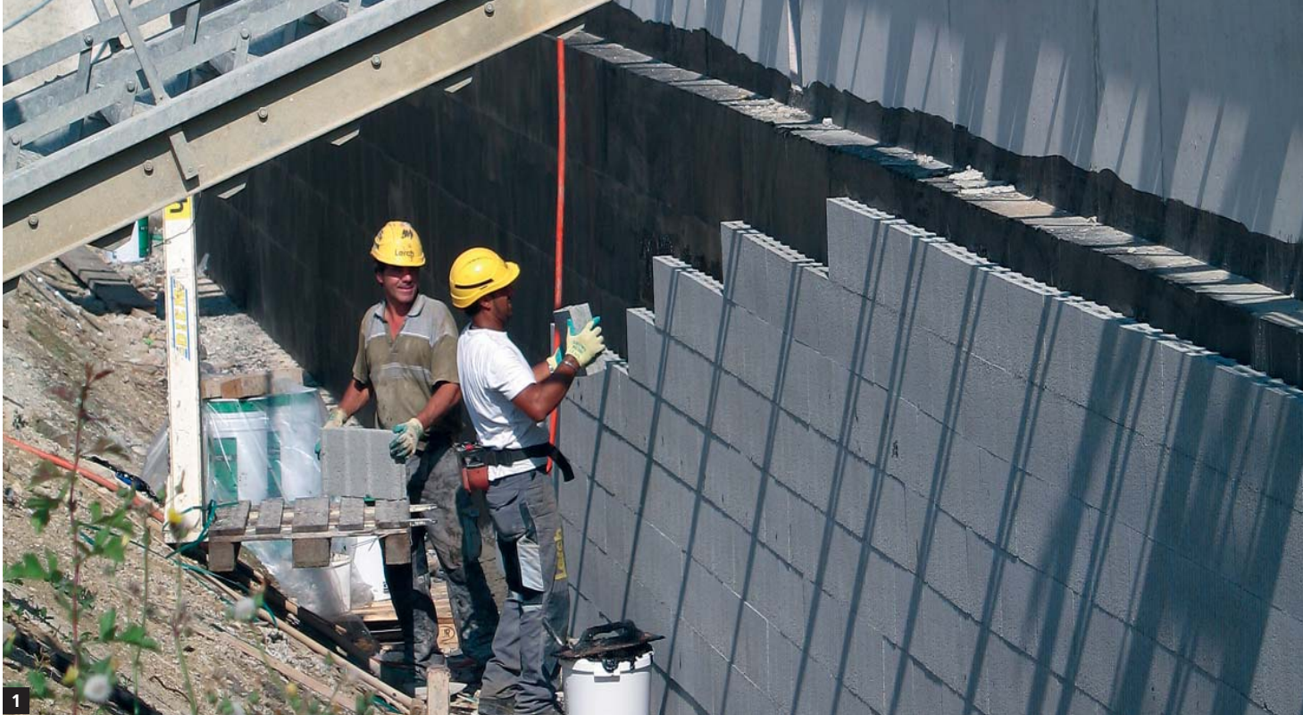
1 Wärmedämmung und gleichzeitig Feuchtigkeitsabdichtung
