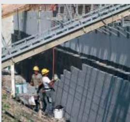
FOAMGLAS® Platten mit Kaltkleber
