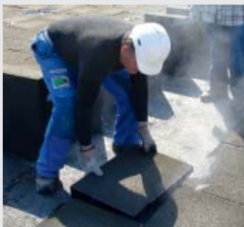
FOAMGLAS® Platten mit Heissbitumen
