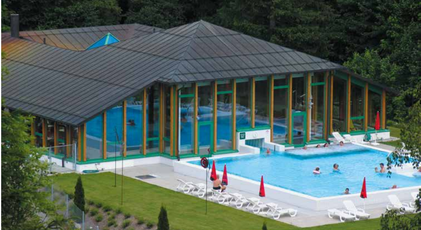
Pływalnia z dachem z pokryciem blachą (miedź), Alvaneu, Szwajcaria – arch. Martin Stöhr
