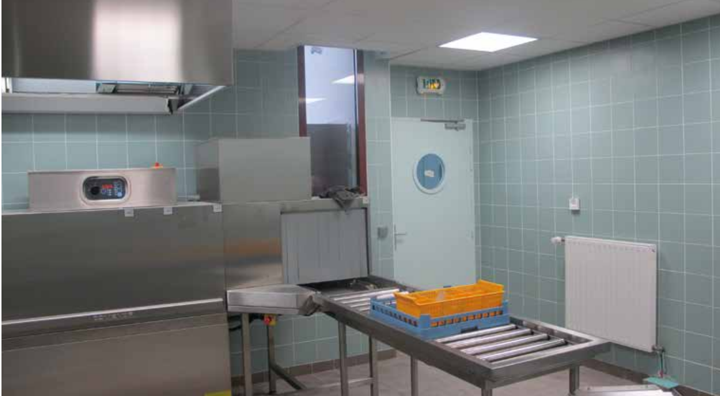
Virtuvės patalpos Louis Pasteur mokykloje, Villejuif – Architektai: Atelier d'architecture Malisan
