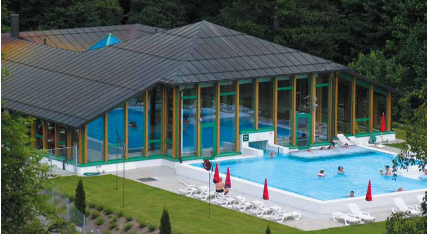
Plaukimo baseinas su variniu stogu, Alvaneu (Šveicarija) – Architektai: Martin Stöhr
