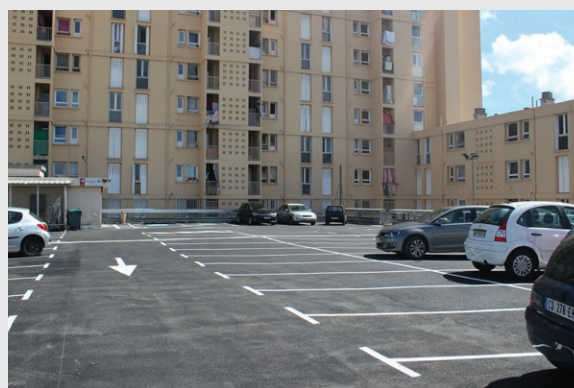
Rénovation parking Carrefour Market Plombières, FR - Marseille
