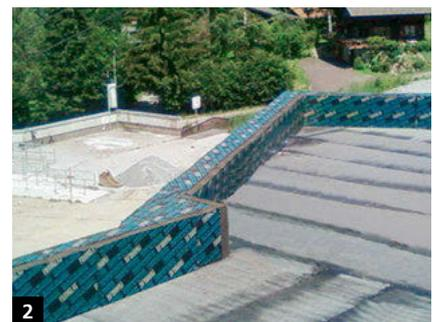
**FOAMGLAS® est stable dimensionnellement (fig. D, page 28). Cette stabilité explique la possibilité, unique, du collage des plaques isolantes entre elles. L'étanchéité est ainsi mise en oeuvre sur une couche isolante continue. De plus, le verre cellulaire résiste à la compression sans tassement, même sous charge de longue durée. Les systèmes d'étanchéité mis en oeuvre sur FOAMGLAS® durent très longtemps.**
