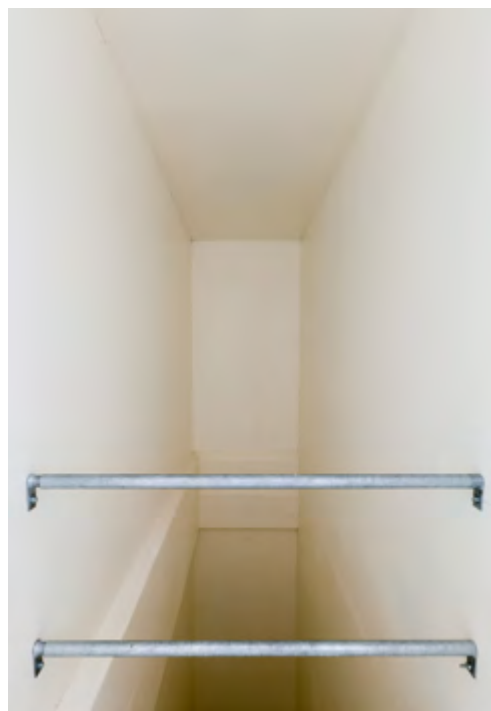
Légende photo : Des conduits d'aération en matériaux FOAMGLAS® incombustibles dotés d'un revêtement PC® 74 A2.
