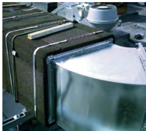
FOAMGLAS® peut être facilement travaillé (ici le conduit en tôle d'un système de ventilation)
