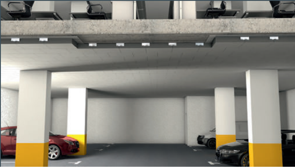
FOAMGLAS® SKYPEARLS, instalacja na stropie garażowym, termoizolacja wewnętrzna, montaż bezpośredni
