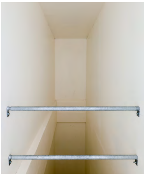
Luchtkanalen gemaakt uit onbrandbare FOAMGLAS®-materialen met een PC® 74 A2-coating
