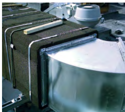
FOAMGLAS® kan makkelijk worden verwerkt (hier het plaatmetalen kanaal van een ventilatiesysteem).
