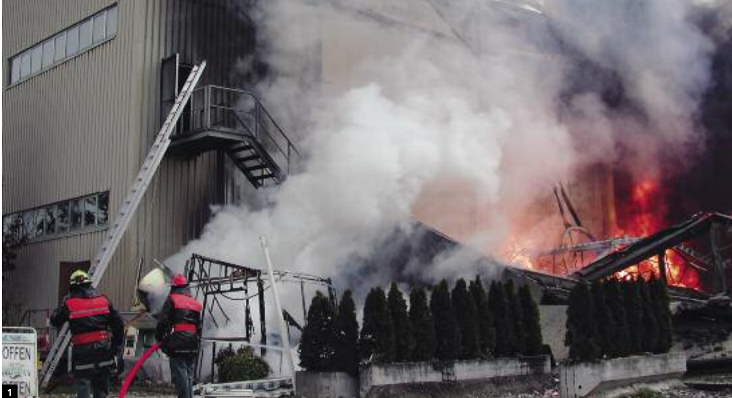
1 La propagation du feu par la façade et le toit est souvent la cause de dommages catastrophiques
