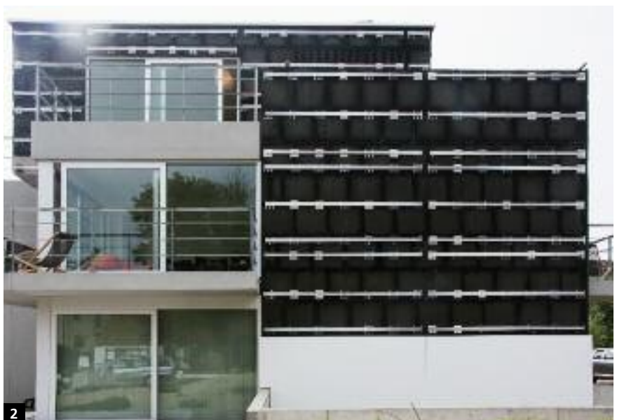
2 Geventileerd gevelsysteem, Appartementsgebouw Oostduinkerke, België
