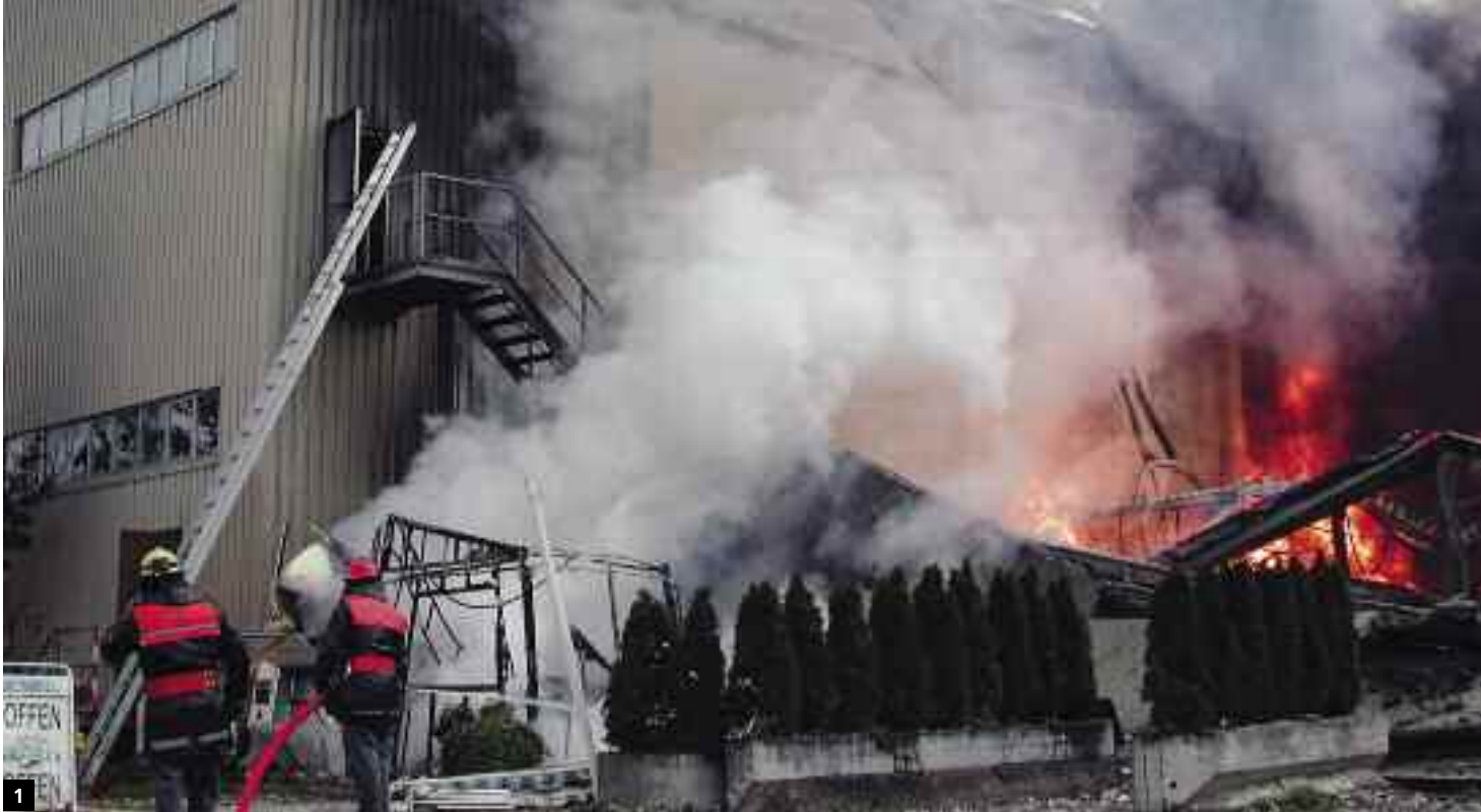
1 Brandausbreitung über Fassade und Dach ist oft Ursache verheerender Gesamtschäden
