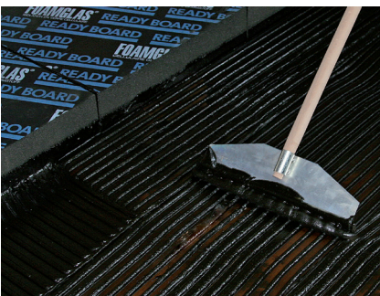
FOAMGLAS® Blocks geklebt mit Kaltkleber (PC® 58 oder PC® 500)
