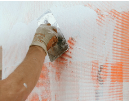
FOAMGLAS® Platten geklebt PC® 56, verputzt (PC® 164, PC® 78) / (PC® 74 A1, PC® FINISH 0, 1 und 2.5)
