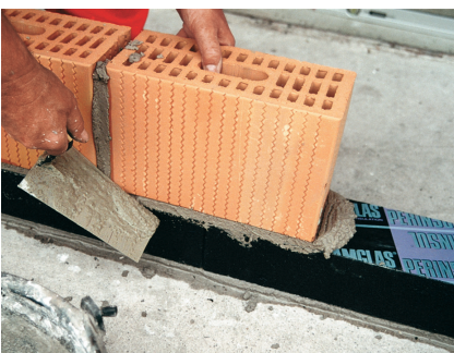
FOAMGLAS® PERINSUL Tragendes Wärmedämmelement für Mauerwerk
