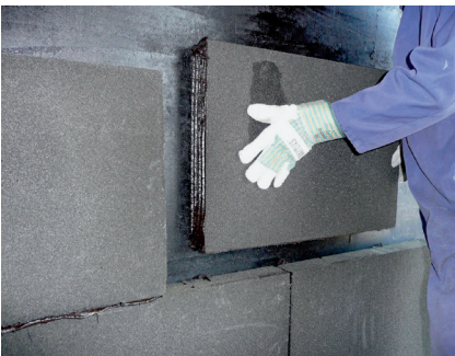
FOAMGLAS® Platten geklebt mit Kaltkleber PC® 56
