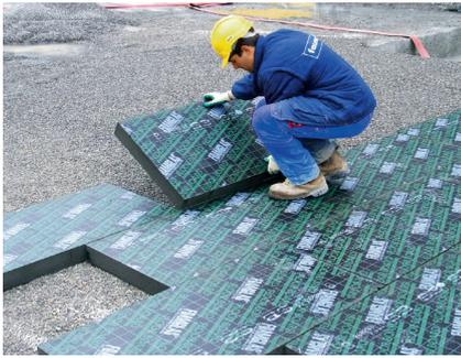
Panneaux FOAMGLAS® Boards, posées à sec
