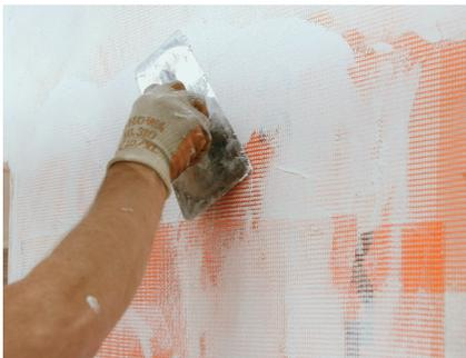
Plaques FOAMGLAS®, collées avec la colle PC® 56 et crépi (PC® 164, PC® 78) / (PC® 74 A1, PC® FINISH 0, 1 et 2.5)
