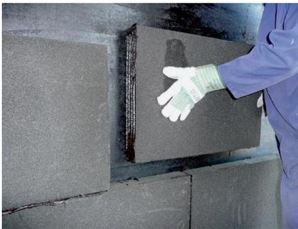
Plaques FOAMGLAS®, posées avec colle à froid PC® 56
