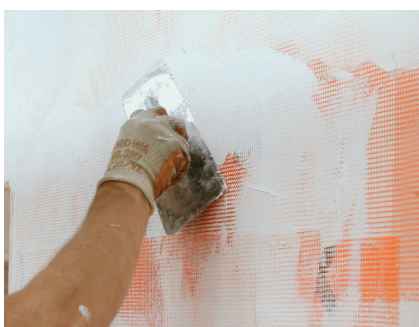
Lastre FOAMGLAS®, incollate con PC® 56 e intonacate (PC® 164, PC® 78) / (PC® 74 A1, PC® FINISH 0, 1 e 2.5)
