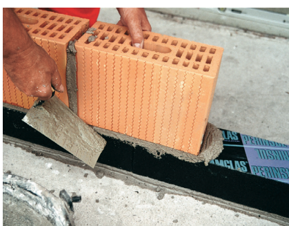
FOAMGLAS® PERINSUL, elemento termoisolante portante per opere murarie
