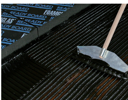
Pannelli FOAMGLAS® Boards, posati con colla a freddo (PC® 58 o PC® 500)
