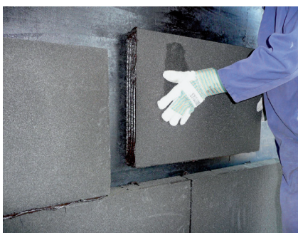
Lastre FOAMGLAS®, posate con colla a freddo PC® 56
