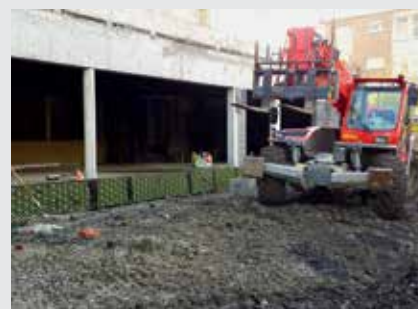
Traitement des soubassements
