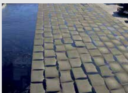
Pose des plaques et panneaux FOAMGLAS® READY BLOCK et T3+
