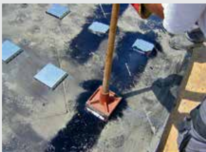
Pose des plaquettes métalliques FOAMGLAS®
