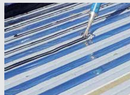
Pose des panneaux FOAMGLAS® - Colle bitumineuse à froid - Traitement acoustique du bac acier perforé
