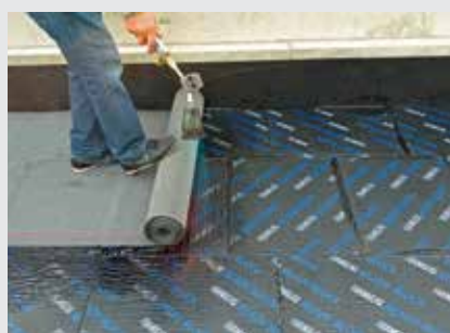
- Pose des panneaux FOAMGLAS® READY BLOCK - Soudage de la membrane d'étanchéité
