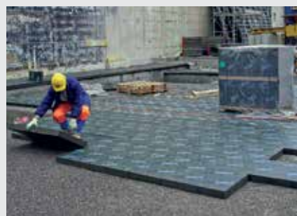
Pose des panneaux FOAMGLAS® BOARD sur une couche d'égalisation de sable / de gravillons
