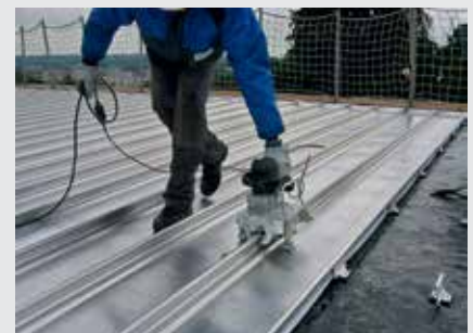
- Système Sarking : pose du litzonnage - Mise en oeuvre de la finition métallique
