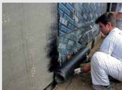
- Pose de FOAMGLAS® BOARD - Soudage de la membrane d'étanchéité en mur enterré
