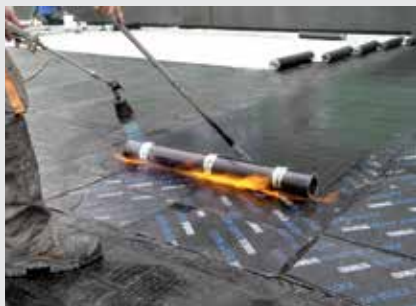
Pose des panneaux FOAMGLAS® READY BLOCK T3+, T4+, S3, F Soudage de la membrane
