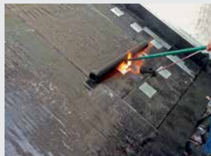
Soudage de la membrane d'étanchéité
