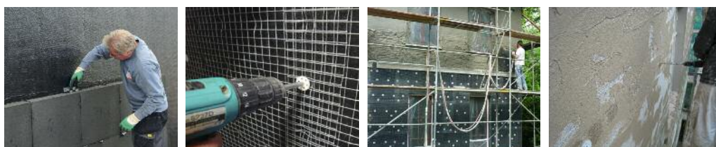
Išorinių tinkuojamų sienų izoliavimo FOAMGLAS® izoliacija tvarka.
