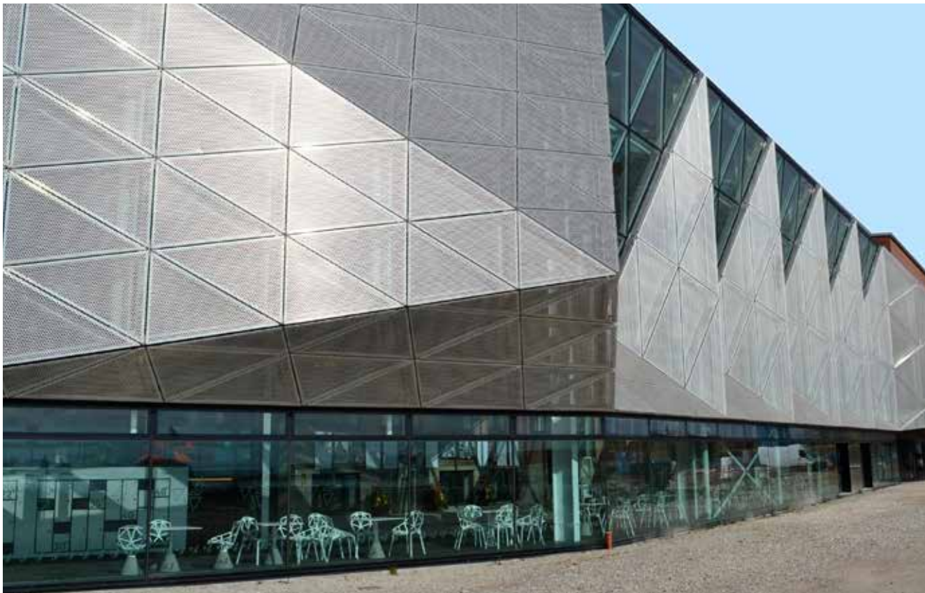
ISOLERING AV TAK - Helsingør Kulturcenter, Danmark
