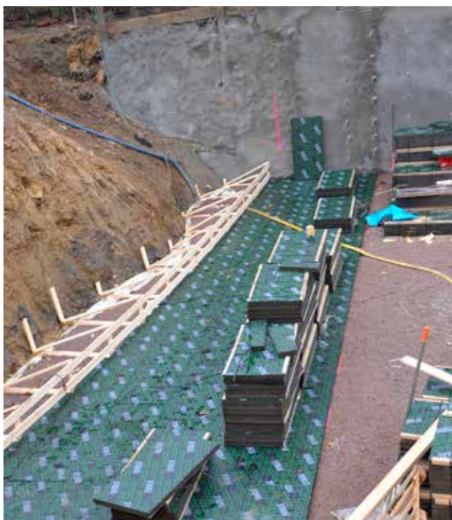
Löst utlagd FOAMGLAS® Floorboard på fingerus.
