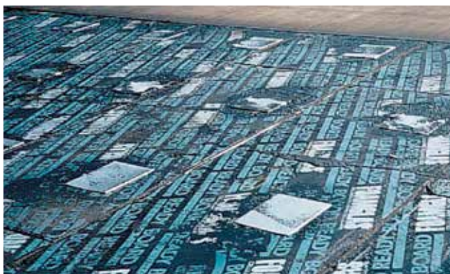
Taggbrickor av galvaniserad stål i FOAMGLAS® READY BOARD
