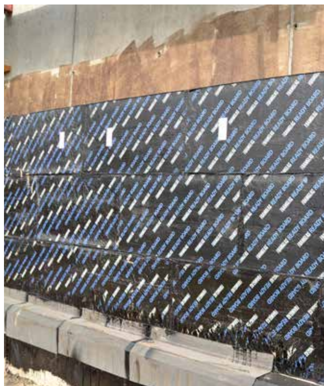
Källarytervägg med FOAMGLAS® READY BOARD förberett för påsvetsning av tätskikt.
