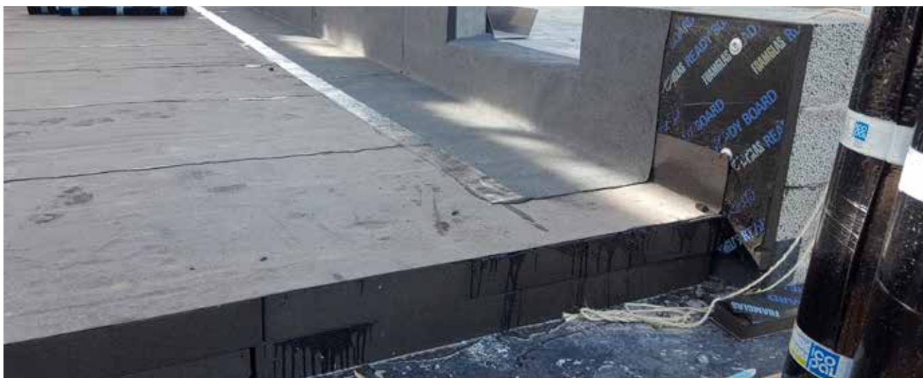
Nästa tätskiktslager svetsas mot det första lagret
