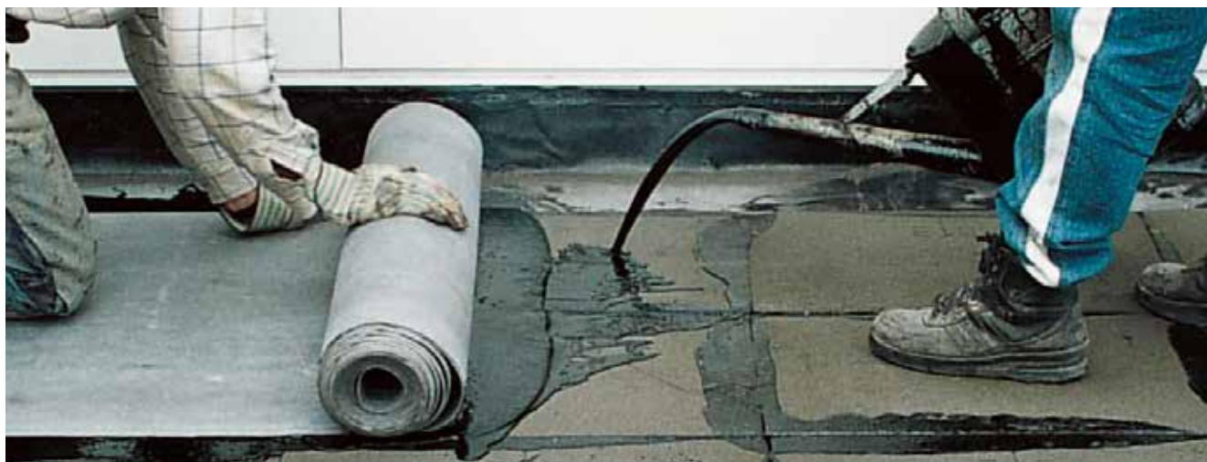
Det första lagret av tätskiktet läggs ovanpå FOAMGLAS®-isoleringen
