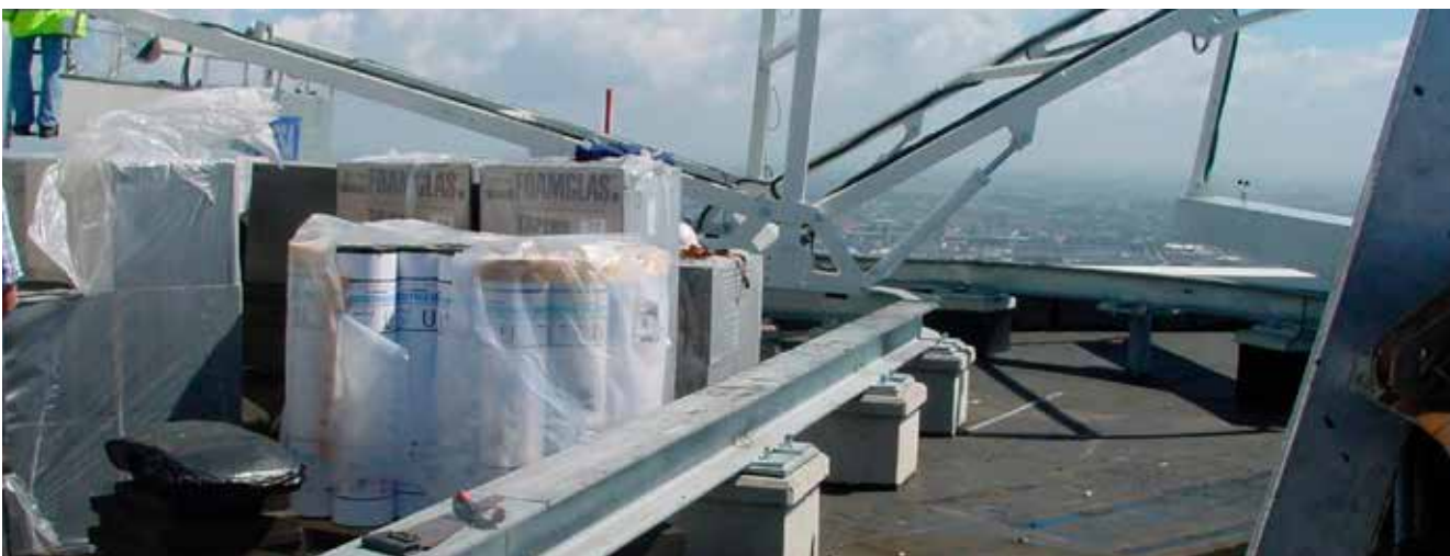
FOAMGLAS PERINSUL, köldbryggebrytare, under fundament till fönsterhiss.
