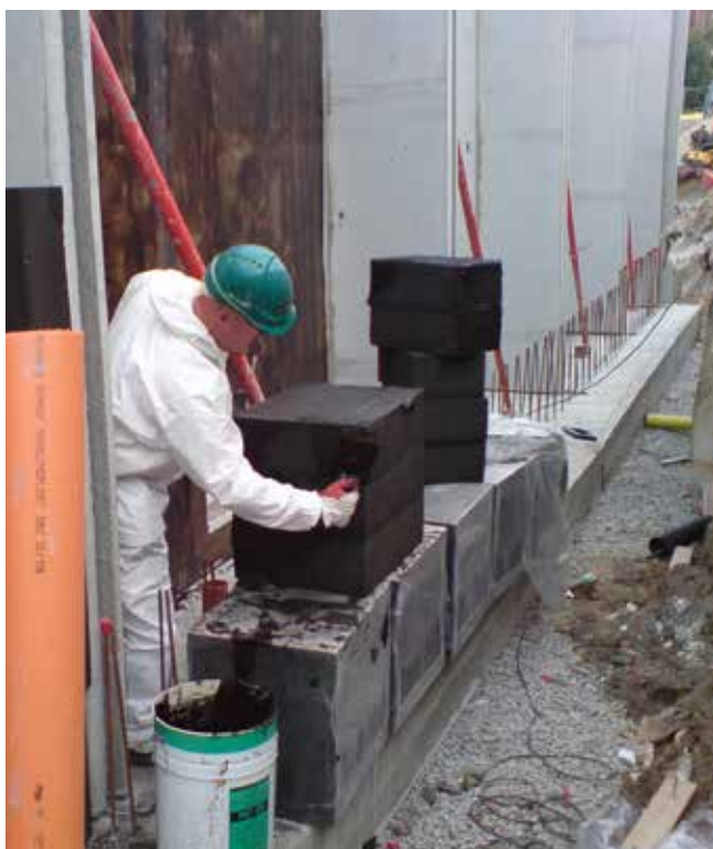
Montering av FOAMGLAS® BLOCK med lim PC56 på källarytervägg.
