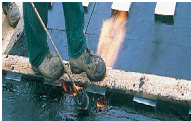
Uppvärmning och nedpressning av taggbrickor
