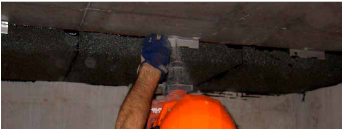
Mekanisk infästning med PC Anker F.
