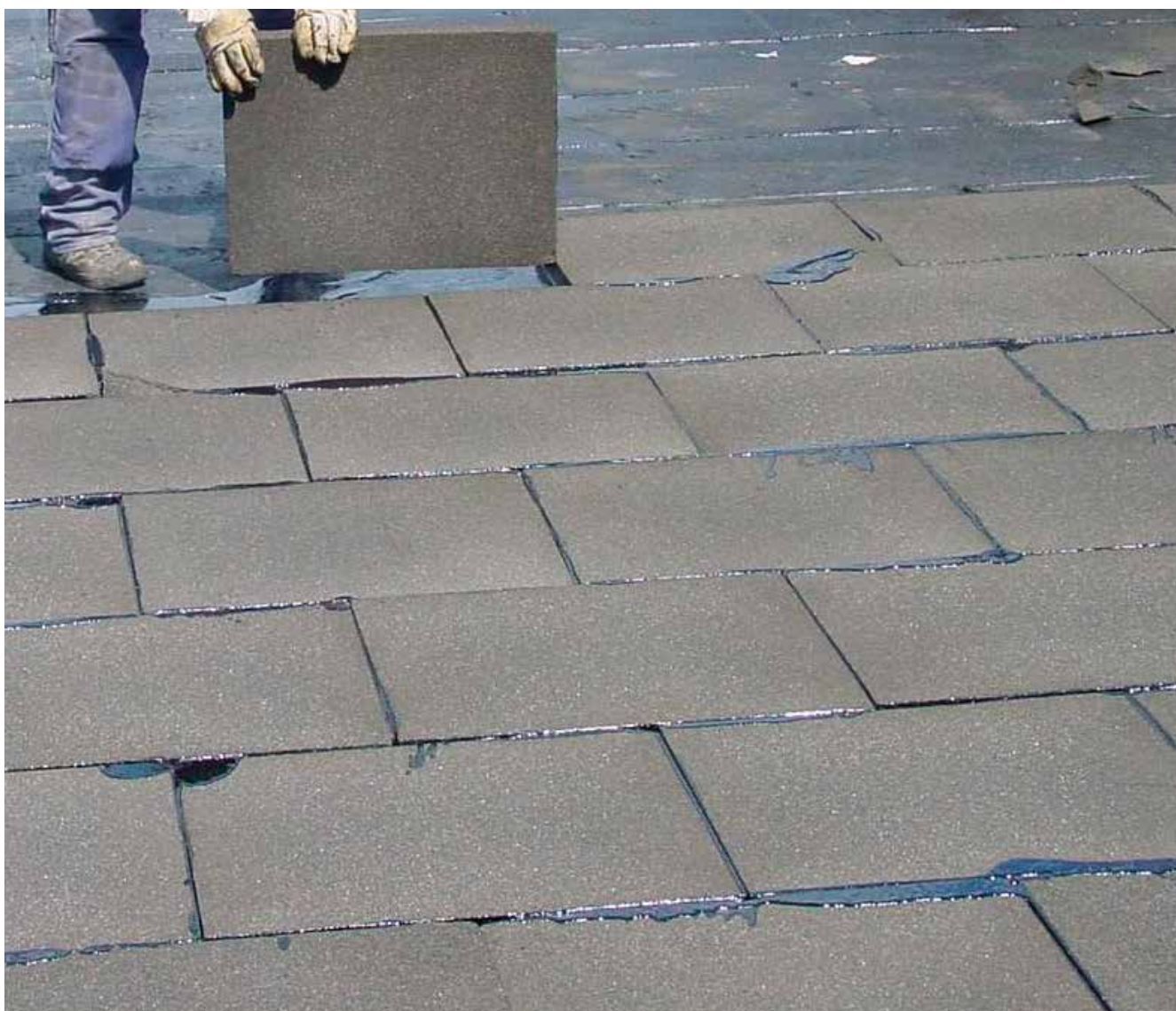
Installerade FOAMGLAS® BLOCK med förskjutna skarvar
