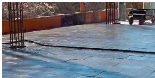
FOAMGLAS® BLOCK lagd i varmasfalt
