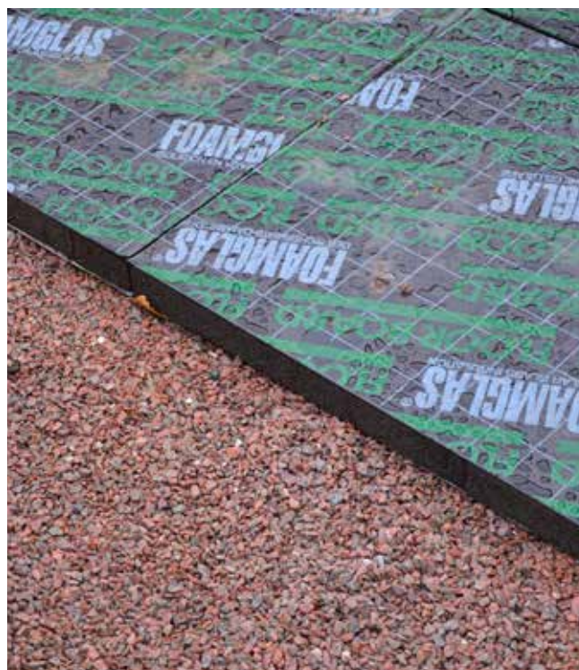
FOAMGLAS® BLOCK lagd i varmasfalt
