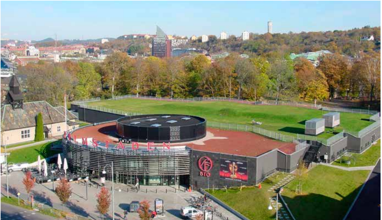
Isolering av grönt tak. Bergakungens Salar, Göteborg.
