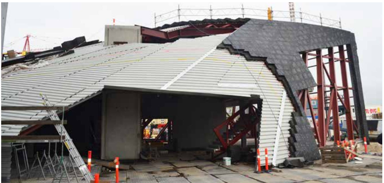
Isolering av fasad med plåtbeklädnad. Musikens hus Århus, Danmark
