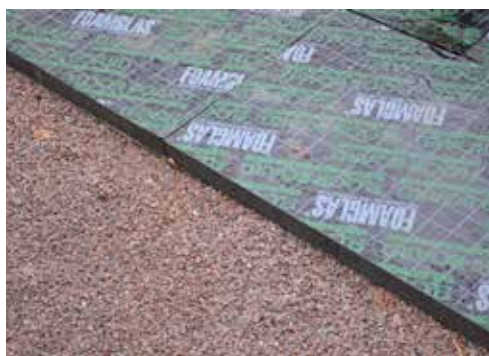
Irralleen asennetut FOAMGLAS® FLOOR BOARD-eristeet sora-alustalla.
