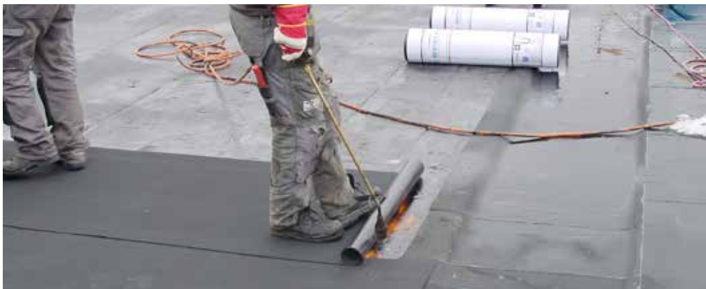
Seuraava bitumikerros hitsataan kiinni ensimmäiseen kerrokseen.
