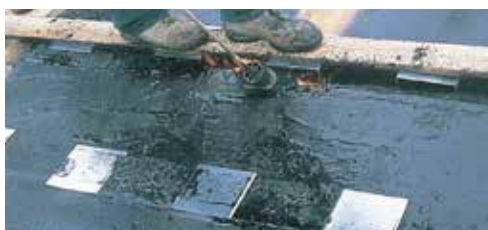
Hammaslevyjen lämmitys ja asennus.
