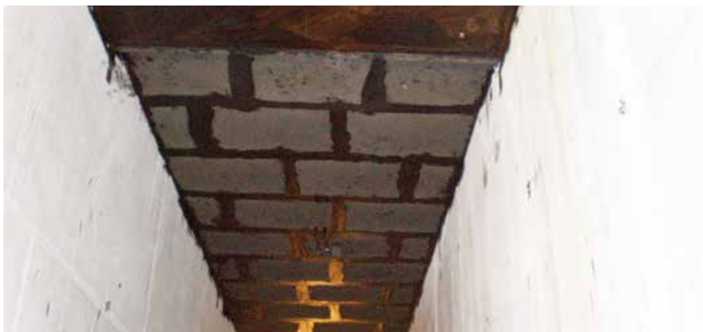
FOAMGLAS® LAATTA liimattuna PC56-liimalla.
