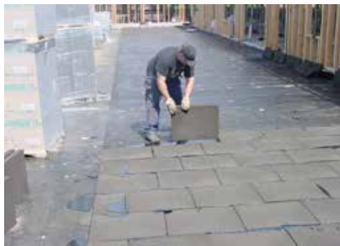
FOAMGLAS® LAATTA -eristeen asennus
