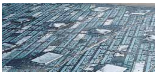
Galvanoidusta teräksestä valmistetut hammaslevyt FOAMGLAS® READY BOARD -eristeessä.
