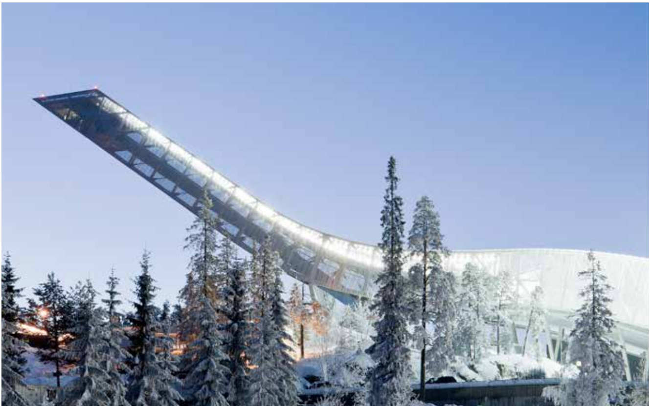
Sisäpuolinen eristys – Holmenkollen, Norja
