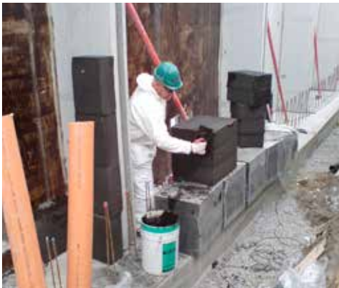
FOAMGLAS® LAATTA -eristeen kiinnitys PC56-liimalla kellarin ulkoseinään.
