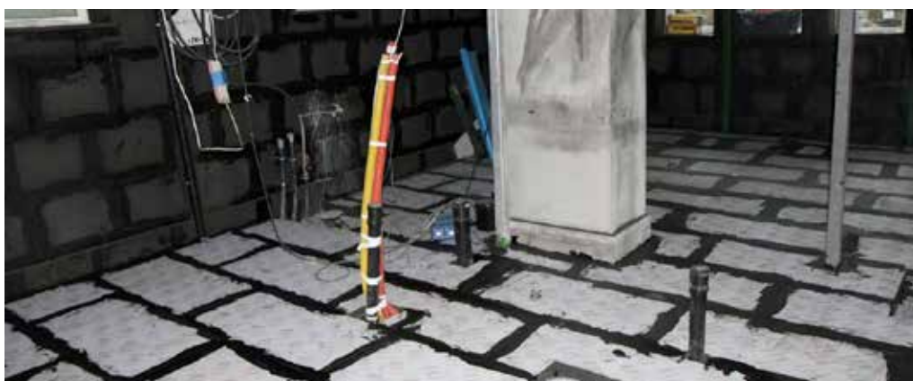
Lattian sisäpuolinen eristys FOAMGLAS® FLOOR BOARD -eristeellä
