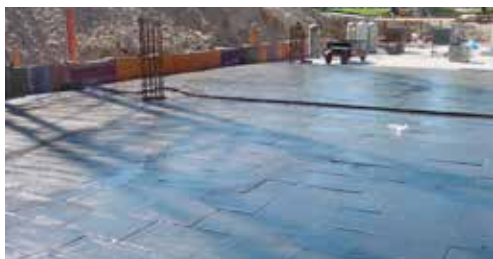
FOAMGLAS® LAATTA asennettuna kuumabitumiin.
