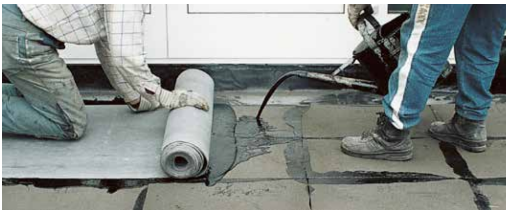
Ensimmäinen bitumikerros asennetaan FOAMGLAS®-eristeen päälle.
