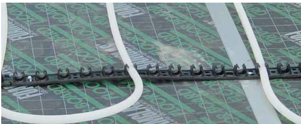
Lattialämmitysjärjestelmä: Sähkökaapelit ja -putket voidaan sijoittaa pintabetoniin tai hiekkakerrokseen eristeen päälle.
