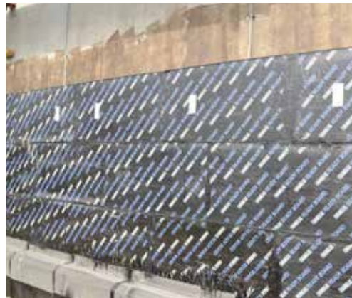
Kellarin ulkoseinä FOAMGLAS® READY BOARD -eristeellä valmisteltuna bitumikermin hitsausta varten.
