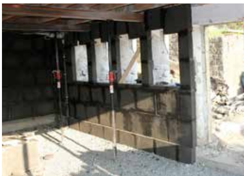
Seinien sisäpuolinen eristys PC56-liimalla.
