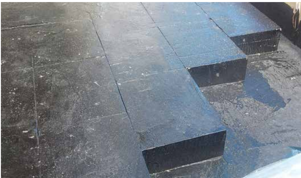
Asennetut FOAMGLAS® LAATTA limitetyillä saumoilla
