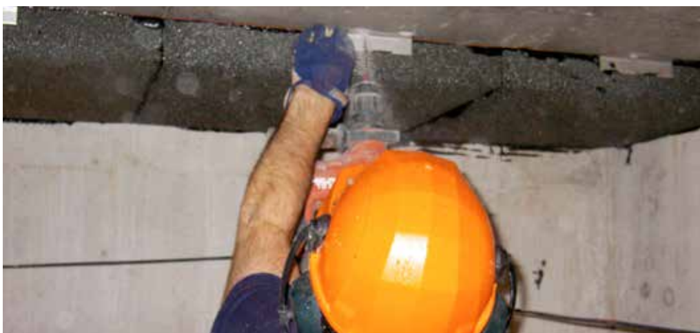
Mekaaninen kiinnitys PC Anker F:llä.
