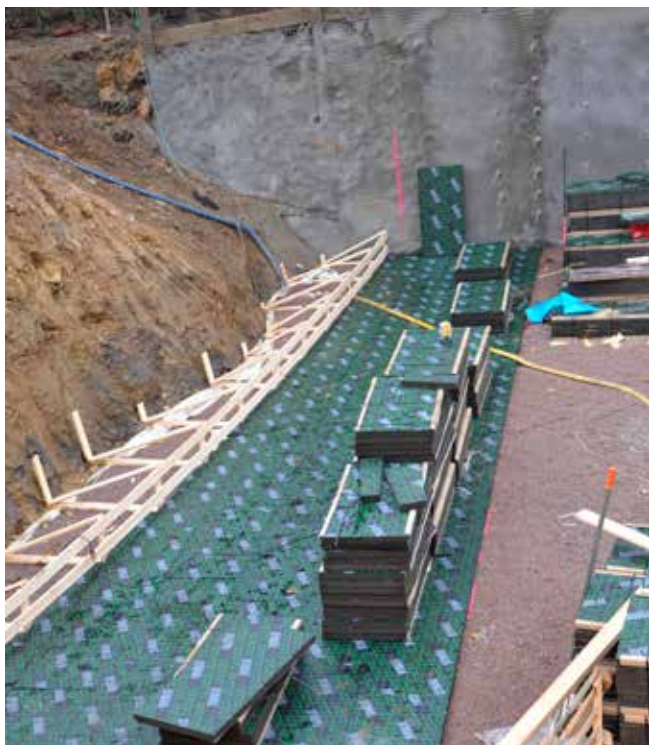
Løst udlagt FOAMGLAS® Floorboard på fingrus.
