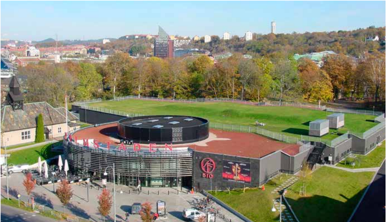
Isolering af grønt tag. Bergakungens Salar, Göteborg.
