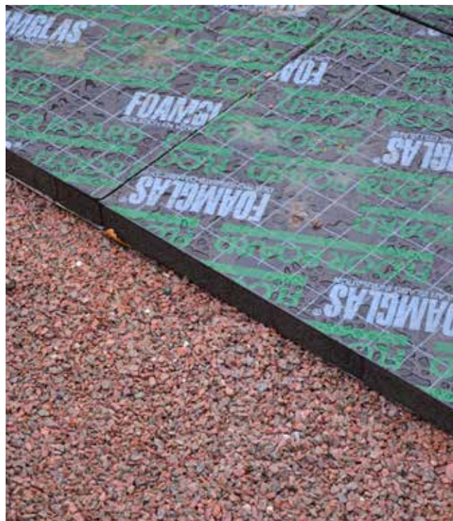
FOAMGLAS® BLOCK lagt i varm asfalt
