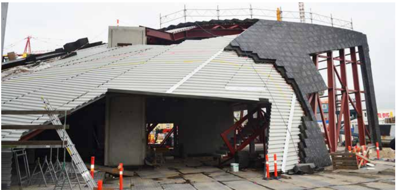
Isolering af facade med pladebeklædning Musikkens Hus, Aalborg
