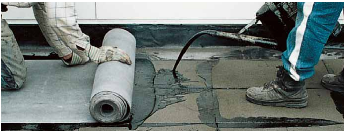
Det første tætningslag lægges oven på FOAMGLAS®-isoleringen.
