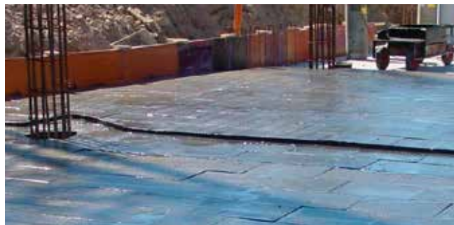
FOAMGLAS® BLOCK lagt i varm asfalt
