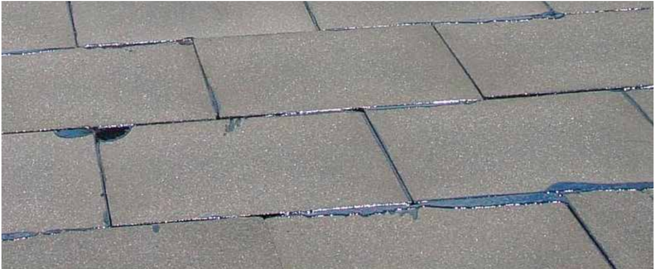
Installerede FOAMGLAS®-BLOKKE med forskudte samlinger
