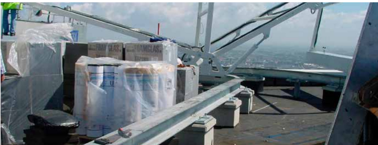
FOAMGLAS PERINSUL, kuldebroafbrydelse, under fundament til vippevinduer.
