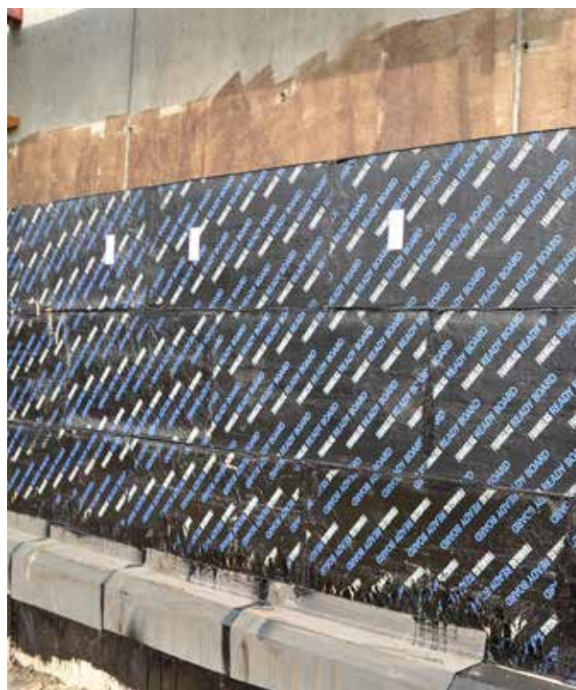
Kælderydervæg med FOAMGLAS® READY BOARD forberedt til påsvejsning af tætningslag.
