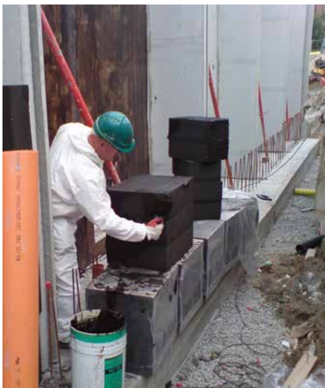
Montering af FOAMGLAS® BLOCK med klæber PC56 på kælderydervæg.
