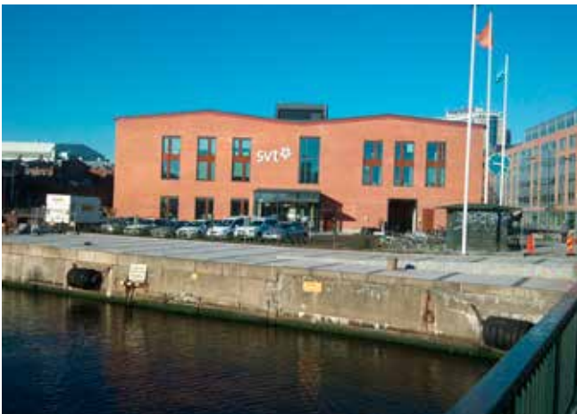
INDVENDIG ISOLERING SVT Studios, Västra Hamnen, Malmö
