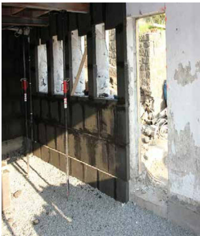
Indvendig isolering af væg med PC 56 klæber.
