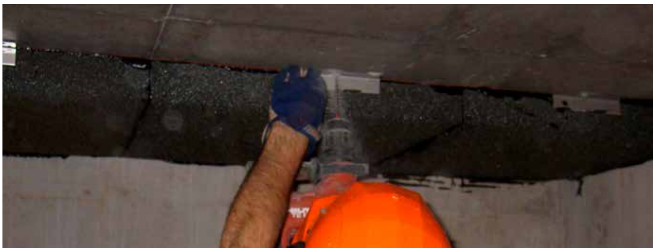
Mekanisk fastgørelse med PC Anker F.
