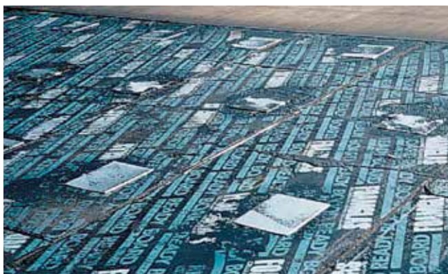
Tagbrikker af galvaniseret stål i FOAMGLAS® READY BOARD
