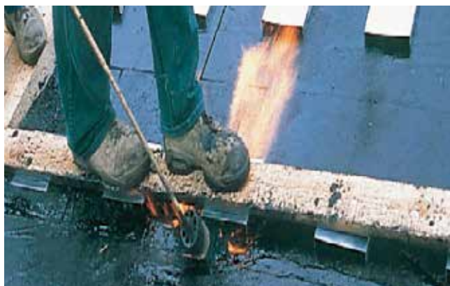
Opvarmning og montage af tagbrikker
