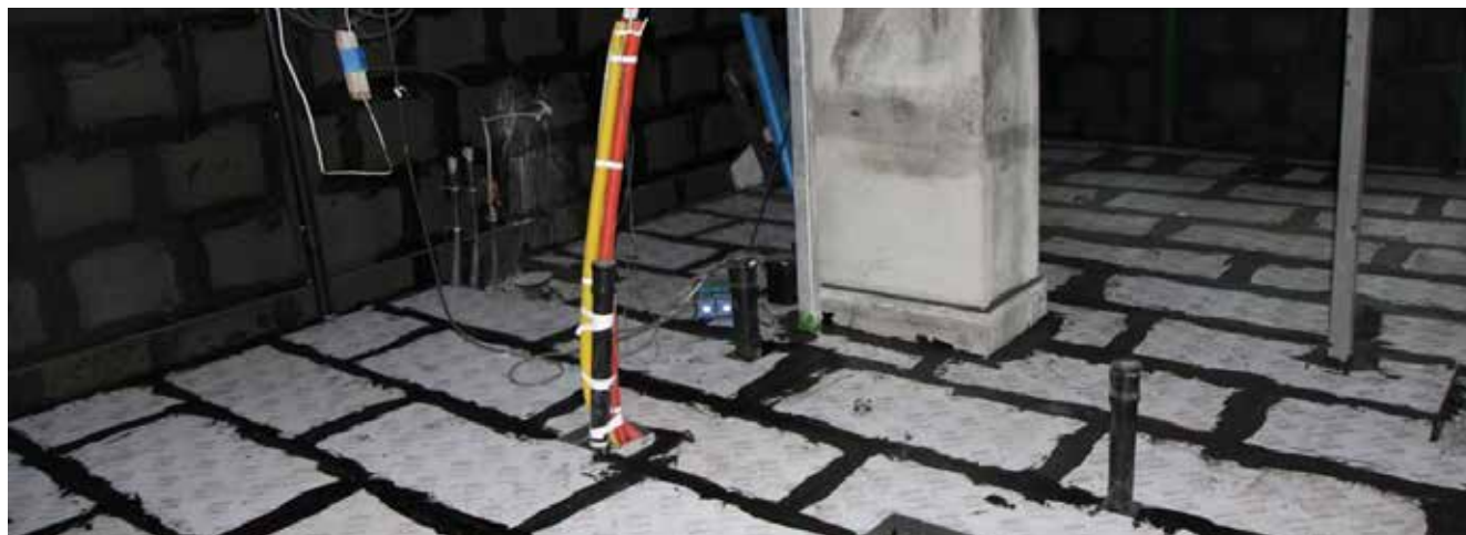
Indvendig isolering af gulv med FOAMGLAS® FLOOR BOARD.
