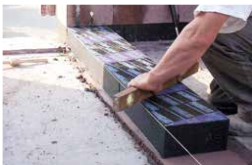
Isoleringselementet kan kombineres med alle vanlige typer og størrelser av murblokker og prefabrikkerte vegger.
