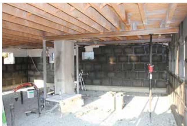
INNVENDIG ISOLERING Villa Are Engum i Bergen
