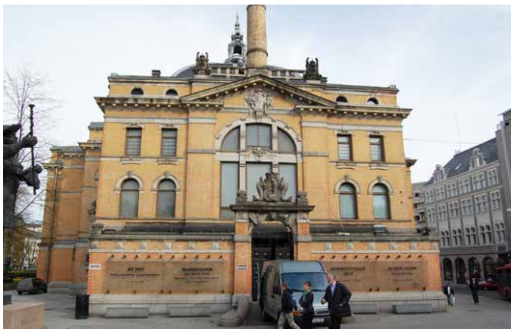
Innvendig isolering av telgvegg, Nasjonalteatret i Oslo
