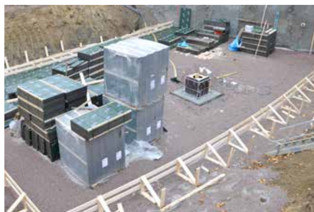
FUNDAMENT Kirke i Maria Park i Helsingborg
