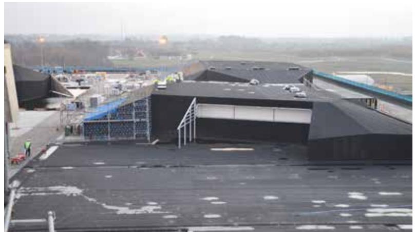
FOAMGLAS®-takfallssystem på Emporia i Malmø.
