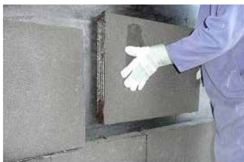
Montering på fasade
