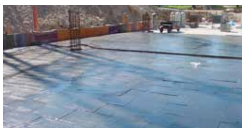
FOAMGLAS® BLOCK lagt i varmasfalt
