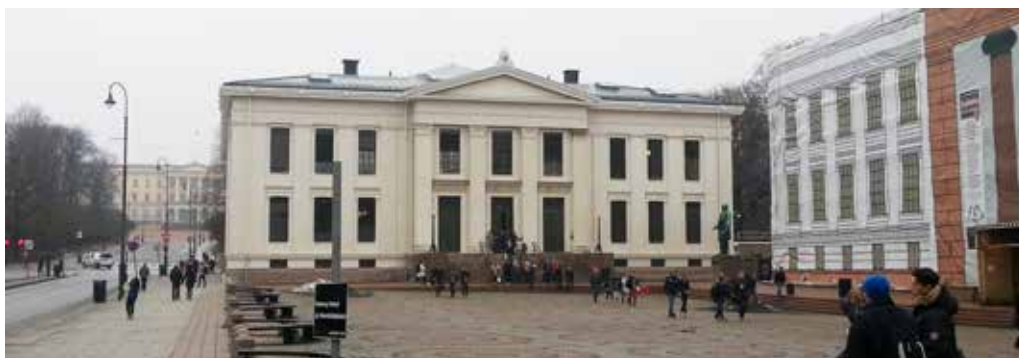
Yttertak, Universitetsbiblioteket UiO i Oslo
