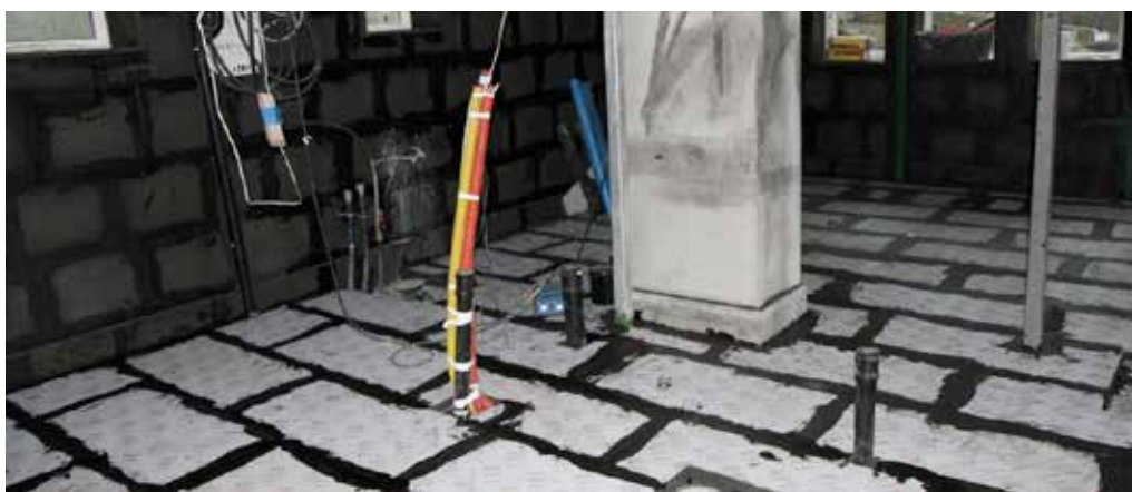
Innvendig isolering av gulv med FOAMGLAS® FLOOR BOARD
