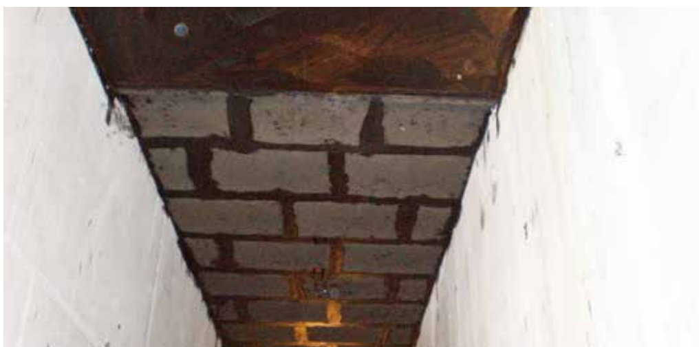
FOAMGLAS® BLOCK limt med PC 56.
