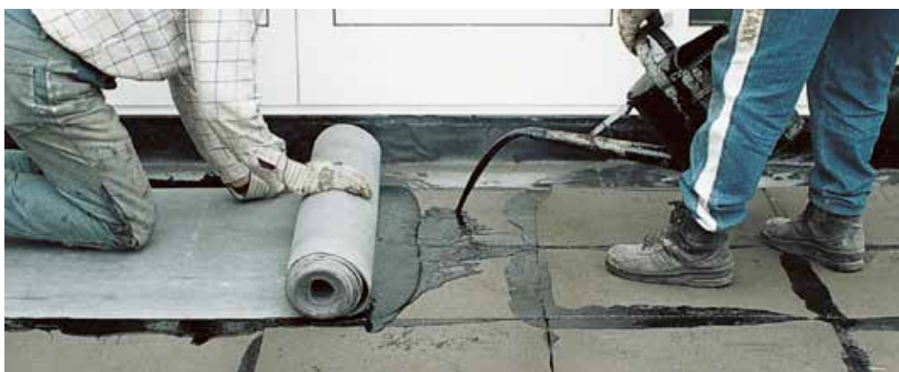
Det første tettesjiktet legges oppå FOAMGLAS®-isoleringen.
