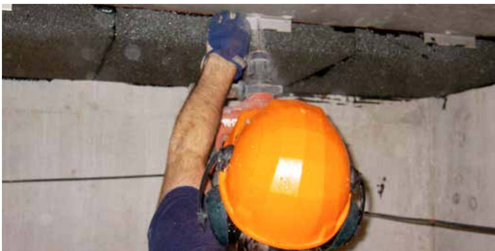
Mekanisk festing med PC F.
