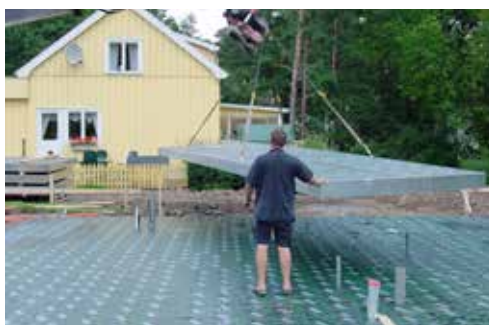
Montering av bunnplate med Koljern®-teknikken
