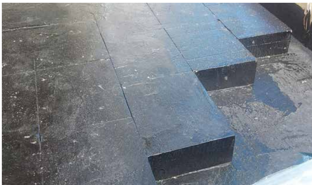
FOAMGLAS® BLOCK lagt med forskjøvede skjøter.
