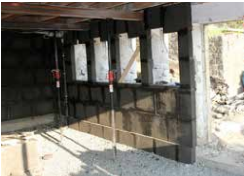
Innvendig isolering av vegg med lim PC 56
