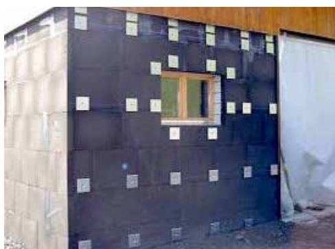
Spikerplater på fasade
