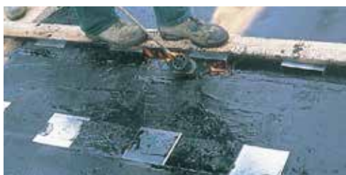
Oppvarming og nedpressing av spikerplatene
