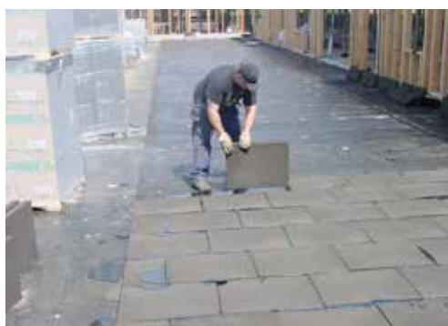
Legging av FOAM-GLAS® BLOCK.
