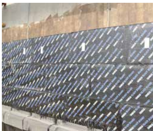
Kjelleryttervegg med FOAMGLAS® READY BOARD klargjort for påsveising av tettesjikt
