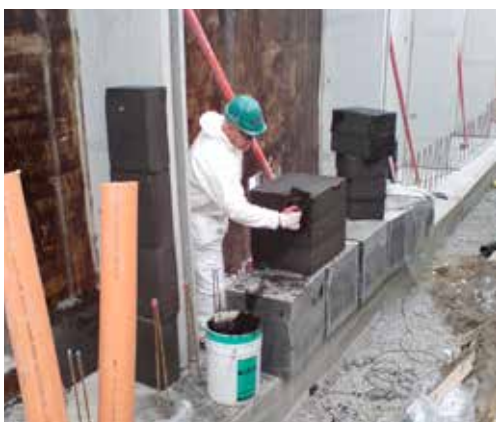
Legging av FOAMGLAS® BLOCK med lim PC 56 på kjelleryttervegg
