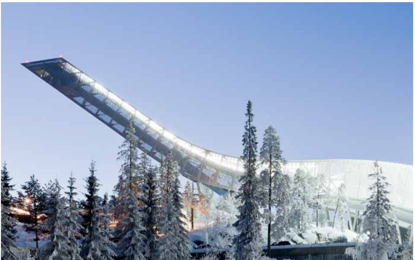
Innvendig isolering – Holmenkollen i Oslo
