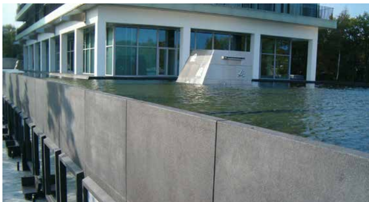
Střešní jezera (modré střechy) Komplex Walterbos, Apeldoorn, Nizozemí
