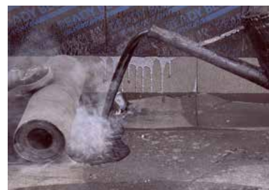
> Lepení prvního asfaltového pásu
