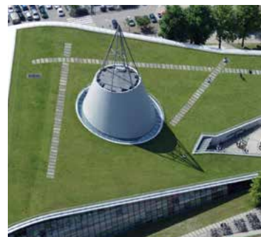
Vegetační střechy ve spádu Technická universita, Delft, Nizozemí
