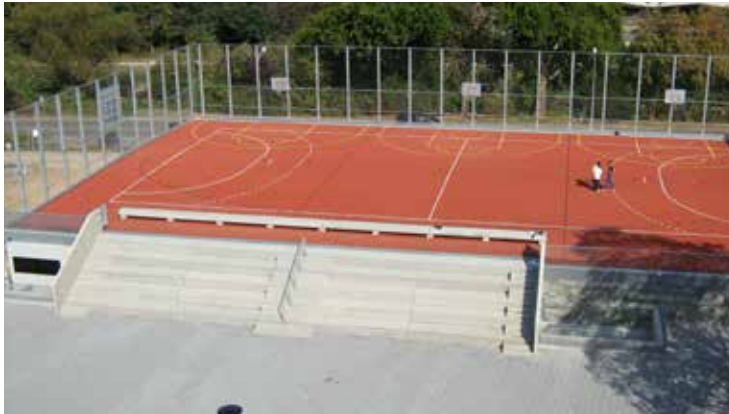
Installations sportives et récréatives sur toits Angel Schule Sportplatz, Freiburg, Allemagne
