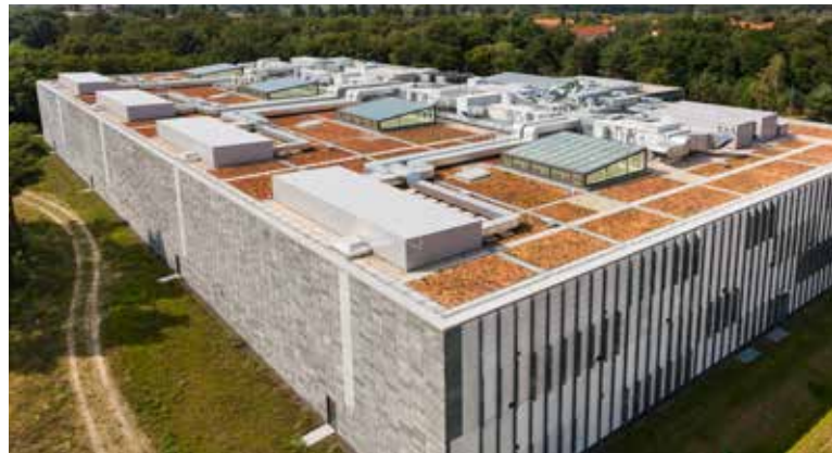
Toits technologiques Metroalde, Bilbao, Espagne
