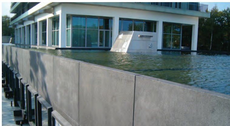
Retentionsdächer Walterbos Complex, Apeldoorn, Niederlande
