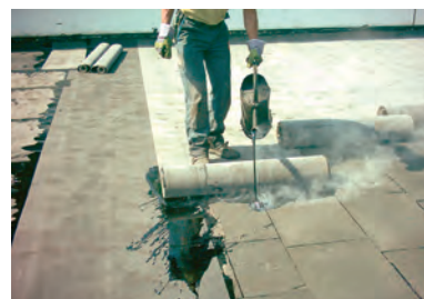
> Erste Abdichtungslage
