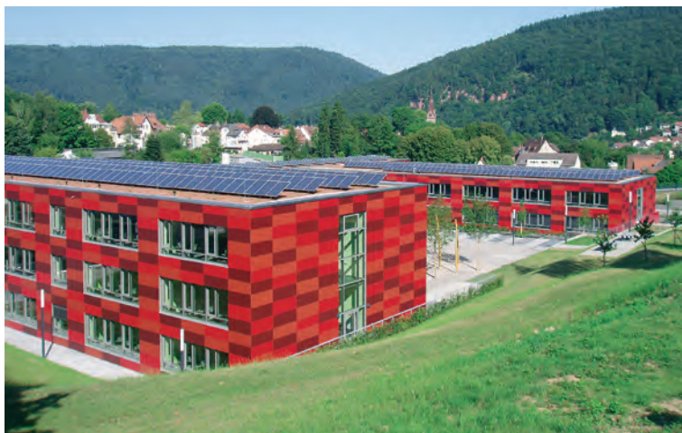
Photovoltaik-Dächer Schulzentrum Neckargemünd, Deutschland
