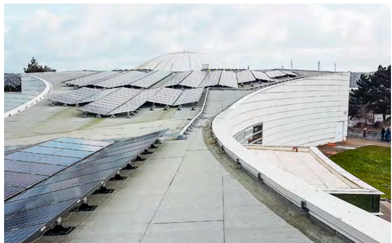
Tetti fotovoltaici Océanopolis, Brest, Francia
