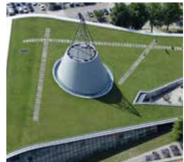
Toiture verte TU, Delft, Pays-Bas
