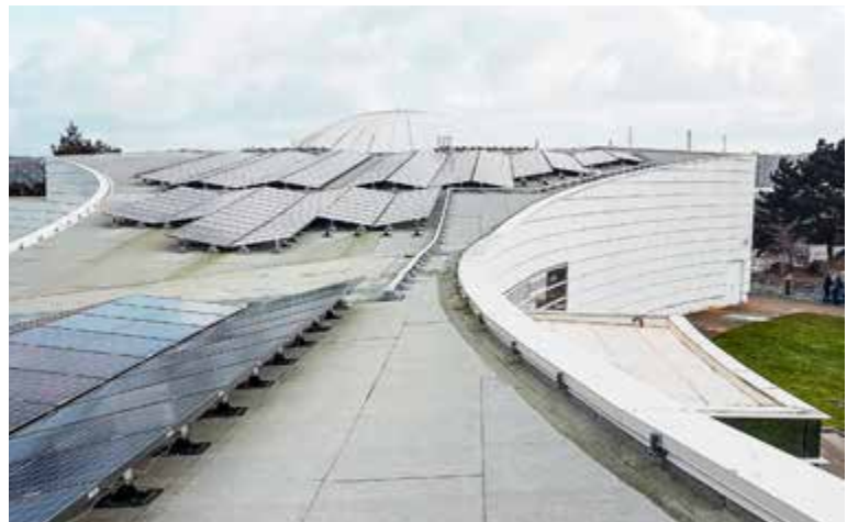
Toitures photovoltaïques Oceanopolis, Brest, France
