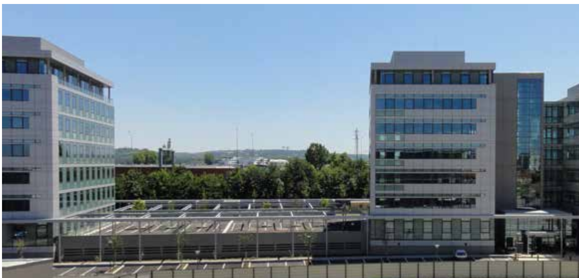
Accessible aux voitures Parking Sud, Toulouse, France
