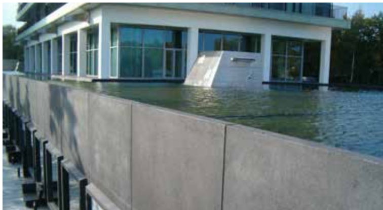
Toitures bleues Le complexe forestier de Walter, Apeldoorn, Pays-Bas
