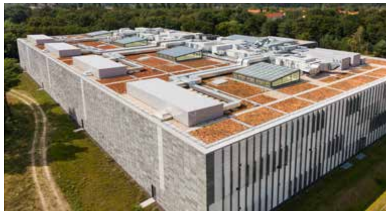
Toits technologiques Metroalde, Bilbao, Espagne
