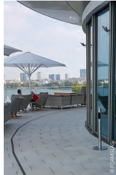
Terrassenflächen Hotel The Fontenay, Hamburg, Deutschland
