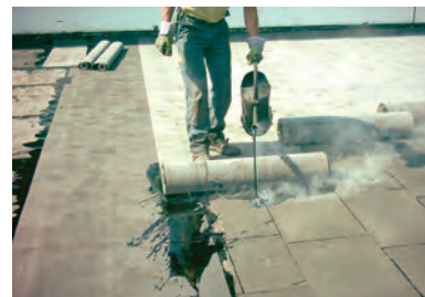
> Erste Abdichtungslage
