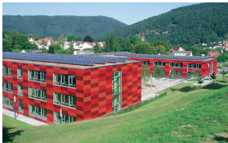
Photovoltaik-Dächer Schulzentrum Neckargemünd, Deutschland
