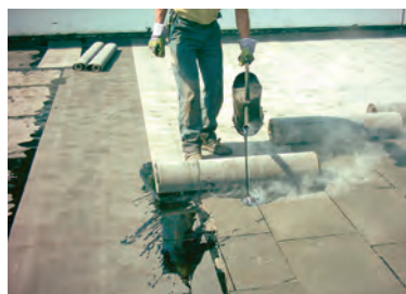
> Erste Abdichtungslage
