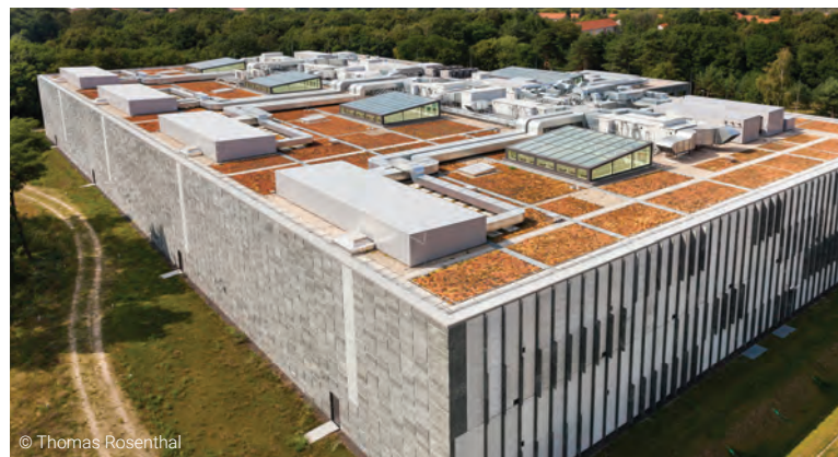
Technikdach Magaziningebäude der Staatsbibliothek, Berlin, Deutschland
