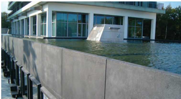
Retentionsdächer Walterbos Complex, Apeldoorn, Niederlande
